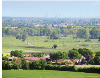
Blick vom Wiehengebirge bei Bergkirchen über die Bastaauniederung zum Kraftwerk Petershagen-Lahde
