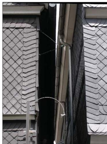
**263** Verkleidungen mit heimischem (links) und ausländischem (rechts) Schiefer. Selbst die Verwitterung des Schiefers lässt langfristig eine Angleichung des zwar gleichen Materials, jedoch nicht des unterschiedlichen Farbtons erreichen. Zur Entscheidung steht daher das heimische Material Schiefer oder andere Baustoffe aus der Region wie Bleche oder Holz.
