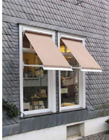
Auch eine Integration der Anlage z.B. innerhalb des Kämpferbereichs (zwischen Fenster und Oberlicht) oder im Bereich des Sturzrahmens hilft, dass die Einrichtungen sich unterordnen und der Fensteröffnung ihre „Schau“ lassen.
