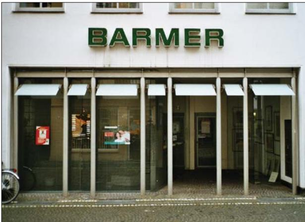
**420** Die Stützen-Struktur aus Stahl steht deutlich in Beziehung zu den Fenstern im Obergeschoss. Die Gliederung ist vorgestellt und trägt die Fassade; dieses erlaubt dann auch, eine durchgehende Schaufensterfront dahinter zurückzusetzen.
