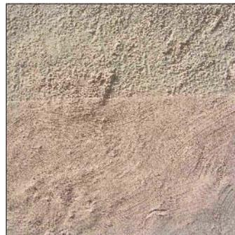
**260** Eine Putz-Oberfläche zeigt unterschiedliche Wirkungen, je nach Glättung und Zuschlagsstoffen („Korn“). Diese bestimmen letztlich aufgrund der Schatten ein helles oder dunkles Erscheinungsbild des Putzes, der recht einfach abgestrichen (oben) und gequastet oder nachgeglättet (unten) wurde.
