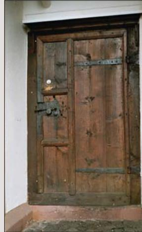
**387 Tür im Mittelalter:** Wie eine Klappe außen angeschlagene und nach außen aufschlagende Tür aus gestoßenen Bohlen mit profilierter Schlagleiste.
