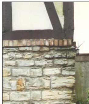
**317+318** Bei einer Abdeckung aus Beton oder mittels einer halbsteinigen Ziegel-Rollschicht kann eine Feuchtigkeitssperre unterhalb der Schicht sinnvoll sein. Dadurch wird auch verhindert, dass das Wasser in das Sockelmauerwerk eindringen kann. Durchfeuchtungen innerhalb der Abdeckung können dort auch wieder abtrocknen. Bei Beton kann zusätzlich eine „Nase“ als Tropfkante („Unterschnitt“) vorgesehen werden.
