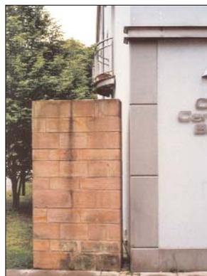
**253+254** Heute entspricht die konstruktive Notwendigkeit eines Vorspringens der Fassade (wie beim Fachwerk) oder Gliederung mittels eines Gesimses (z.B. bei einer Putzfassade) nicht mehr dem Zeitgeist. Dennoch braucht eine Außenwand eine Untergliederung, die sich nicht nur aus den Öffnungen herleitet. Als Materialien können hierbei durchaus Stahlprofile als „zeitgemäßes Zitat“ für einen Vorsprung verwendet werden.
