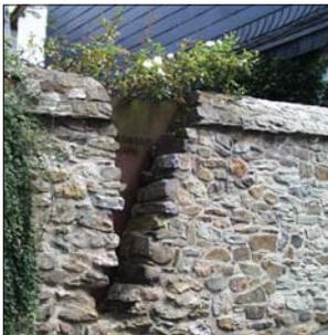
**466** Stadtmauer-Reste Mauern als Einfriedungen, da liegt es nahe, sich an den vorhandenen Mauern zu orientieren. Diese sind aus örtlichem Bruchstein (meist Grauwacke) erstellt und handwerklich ausgeführt. In der Regel bedarf es dafür einer Abdeckung mittels einer Platte aus Sandstein oder aber als halbrund oder dreieckig gemauerter Abschluss. Mauern können ruhig bis 1,80 m „mannshoch“ sein, dann wirken sie als Raumkante.
