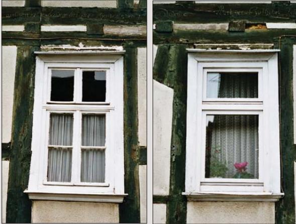
**361+362** Das urprüngliche, 4-geteilte Fenster mit einem unteren Flügelpaar und einem Oberlicht war in der Vergangenheit erneuerungsbedürftig geworden (Abb. 361). Ein Ersatz durch ein einfaches, einflügeliges Fenster mit Oberlicht war schnell gefunden (Abb. 362).
