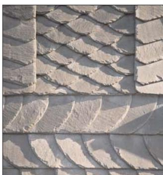
**35** Als Wandverkleidung lässt der Naturschiefer vielfältige Formen und Muster in der unterschiedlichen Anordnung der Schuppen zu. Brechkanten und Oberflächenstruktur tragen zusätzlich zu einem lebhaften Bild des Naturmaterials – insbesondere aufgrund entsprechender Lichtverhältnisse bei.
