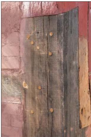
**321** Ein beschädigter Ständer wird nicht einfach abgeschnitten und untermauert, sondern material- und handwerksgerecht „angeschuht“. Dabei ist die Schnittkante so abzuschrägen, dass anfallendes Wasser abfließen und nicht in die Schnittstelle hineinlaufen kann. Es hat sich übrigens bewährt, hierfür alte, gebrauchte Hölzer nicht allein wegen des Aussehens, sondern vor allem wegen der vergleichbaren Verhaltungsweise (bei Feuchtigkeitsaufnahme sowie beim Trocknen und Schwinden) einzusetzen.
