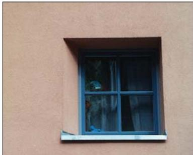
**261** Rauputz, bei dem das „Korn“ des Zuschlagsstoffes die Oberfläche aufgeraut erscheinen läßt. Diese Struktur wirkt zwar dunkler als ein glatter Putz, nimmt aber auch eher als dieser Staubpartikel aus der Luft auf und wirkt dann schnell schmutzig.
