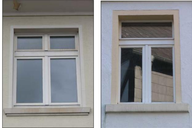
**250+251** Die Form der Verkleidung ist auch häufig bei verputzten Außenwänden übernommen und später im Historismus entsprechend durch Rahmungen in (Zement-) Stuck weitergeführt worden. Durch diese Art der Gestaltung ist die Öffnung in der Außenwand aufmerksam gegliedert und besonders betont worden.
