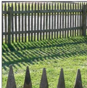
**467** Einfriedung durch Holz-Staketen Die vertikale Ausrichtung der Staketen ist typisch und im Übrigen materialgerecht. Die Spitze kann durchaus – weniger martialisch – stumpfer ausfallen. Ursprünglich dienten diese zur Abwehr von Wildtieren und unerwünschten Personen. Heute ist die Wirkung teilweise ähnlich: Hier beginnt das Grundstück, das Betreten gestattet der Eigentümer! Anpflanzungen helfen jedoch den wehrhaften Charakter zu mildern.
