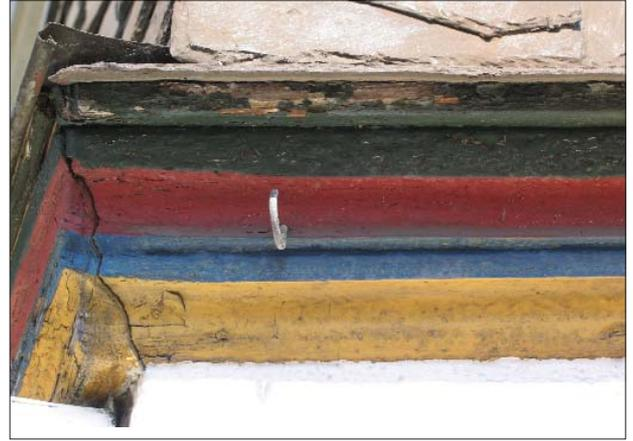
**294** Die Füllhölzer zwischen den Balkenlagen der verschiedenen Geschosse sind nicht nur profiliert, sondern auch farbig abgesetzt. Die Farbgebung folgt einfachen Regeln entweder mit den Grundfarben Rot, Blau und Gelb...
