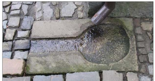
**473** Solche Flächen sind anders zu behandeln: „Wildpflaster“ (Wallstraße) in den seitlichen Flächen des Gebäudes zur Drainage der Fundamente und des Sockels. Besonders reizvoll ist das Werkstein-Element aus Sandstein zum Auffangen und Weiterleiten des anfallenden Regenwassers.
