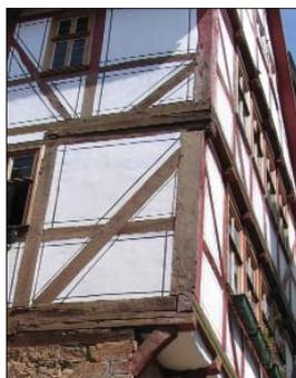
23 Verkämmung (Füllholz zwischen Schwelle und Rähm)
