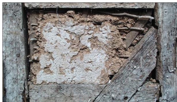
28 Merkmale einer Fachwerkwand sind die flächenbündig ausgefüllten Felder („Gefache“) zwischen den einzelnen Fachwerkhölzern. Örtliche Lehmvorkommen, mit Strohhäcksel vermischt, auf eingeschobenen Staken („Zenkholzer“) und (Weiden-) Flechtwerk („Spellhölzer“) boten die notwendige Haltbarkeit und ausreichenden klimatischen Abschluss zwischen Innen und Außen.
