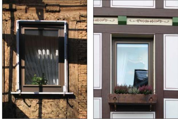
**266+267** Bei der Abnahme der Schiefer-Bekleidung tritt häufig altes Fachwerk zu Tage (hier datiert 1776). Die Frage, was man nun mit der Außenwand macht, stellt sich dann meist völlig neu, vor allem bei Maßnahmen der Wärmedämmung. Die hier gewählte Lösung eines Blendfachwerks ist unglücklich zum einen, weil das historische Bild wieder verdeckt wird, und zum anderen, weil mit Bohlen und Brettern kein echtes Fachwerk entstehen kann.
