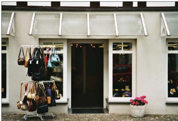
**421** Die knappe, weitgehend transparente Konstruktion aus Stahl und Glas lässt dem Fachwerk seine „Schau“. Die Überdachung bleibt zurückhaltend, dient jedoch nur als Witterungsschutz gegen Regen. Als Sonnenschutz sind geschlossene Materialien geeignet, die dann optisch stärker zur Wirkung kommen.
