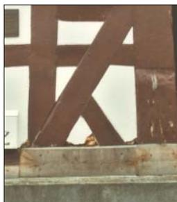
22 Der Ersatz von zerstörten Fachwerkhölzern durch Aufsetzen von Bohlen zeigt deutlich die Ergänzungen. Das ist inzwischen eine von der Denkmalpflege anerkannte Detaillösung. Gleichzeitig ist es wichtig, die Ursachen der Schäden zu beheben (z.B. stehendes Wasser auf dem Sockelvorsprung), weil andernfalls die Zerstörung nicht aufgehalten wird.
