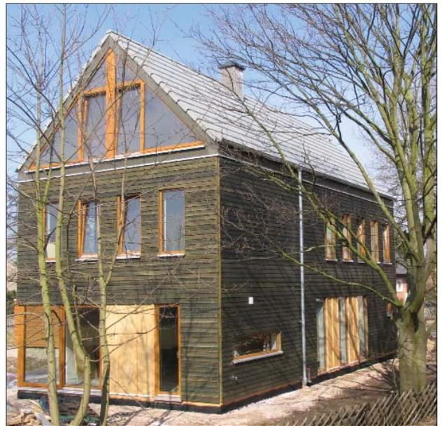
**273** Verkleidungen mit Holz sind auch heute zeitgemäß, wenn es darum geht, mit nachwachsenden Rohstoffen zu bauen. Stülpschalung oder auch andere horizontale Verlegformen z.B. mittels Holzleisten sind jedoch verstärkt den Witterungseinflüssen ausgesetzt als eine senkrechte Holz-Verschalung. Langfristig kann ein lasierender Schutz-Anstrich dagegen auch nichts ausrichten. Naturbelassenes verlegtes Holz kann verwittern und – bei richtiger Anbringung – jahrzehntlang alt werden.
