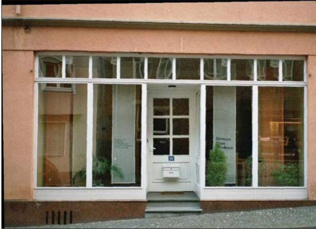
**419** Die nahezu Gebäude-breite Öffnung lässt sich auch mittels der Teilungen durch Fensterhölzer gliedern. Dadurch wird erreicht, dass sich die Proportionen der Fenster innerhalb der gesamten Fassade untereinander angleichen.
