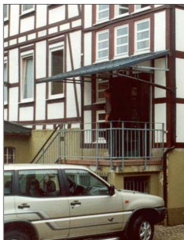
**423** Ein Überdach mit Blechabdeckung kann knappe Dimensionen beibehalten. Die Abführung des Regenwassers z.B. mittels einer Kette durch Einleiten in den ohnehin notwendigen Hofeinlauf würde die aufwändige Führung eines Fallrohrs ersparen und zur Leichtigkeit der ganzen Konstruktion beitragen.
