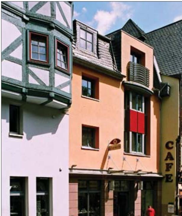
**255+256** Die Gliederung eines Gebäudes kann mittels eines eingeschobenen Erkers oder Zwerchhauses erreicht werden, der sich bis in das Dach fortsetzt. Dabei lassen sich durchaus zeitgemäße Formen und Materialien einsetzen, die sich deutlich unterordnen. Dennoch wird diese Einfügung unserer Zeit zuzurechnen sein.
