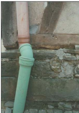
313 Die Grundschwelle des Fachwerkgerüsts liegt auf dem ebenen Sockel quasi „im Wasser“. Eine nachträglich aufgebraute Abdeckung aus Zementspeis (rechts) hat ihre Wirkung verfehlt. Die Schwelle liegt weiter im Feuchten und der Speis verhindert ein Abtrocknen. Die Baustoffe Mauerwerk und Holz haben sich zusammen mit Frost und Hitze bereits erfolgreich gewehrt und den Zementstreifen wieder abplatzen lassen. Hier ist ausschließlich eine Erneuerung des Sockelbereichs angeraten.
