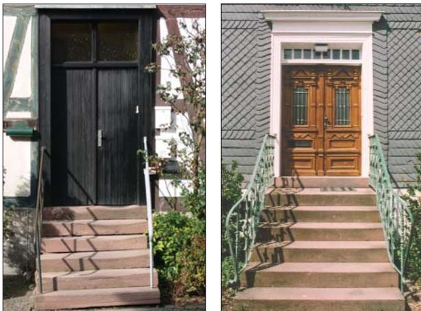
**403+404** Massive Blockstufen aus Naturstein (Roter Sandstein) sind Teil der Eingangssituation eines Hauses.
