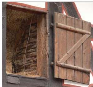
**373+374** Die Öffnung in der Fachwerkwand zum Heuboden wird durch eine einflügelige Holzklappe geschlossen. Diese reicht als Raumabschluss aus. Bei Wohn- und Aufenthaltsräumen diente später ein Klappladen, um den Einblick zu verwehren sowie um die Räume vor Hitze und Kälte zu schützen. Diese Funktion ist auch heute aktuell und wird als Bedarf für zeitgemäßes Wohnen eingefordert.
