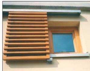
**383+384** Der gewünschte Schutz vor Einblick und Witterung lässt sich auch als Schiebeladen ausbilden. Diese Form ist jedoch eher für Putzfassaden geeignet, da sie mehr Platz und technische Vorkehrungen benötigen. Es ist jedoch in allen Fällen besonderer Wert darauf zu legen, dass sie in knappen Abmessungen ausgeführt werden.
