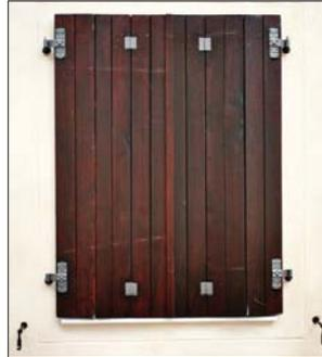
**379+380** Selbst geschlossene Klappläden sind reizvoll und erfüllen ihren Zweck als Sicht- und Witterungsschutz. Das Schließen muss entweder etwas mühevoll per Hand oder alternativ mittels technischer Vorrichtungen erfolgen. Das hat über lange Zeit dazu geführt, diese Form durch andere Einrichtungen (Rollläden o.ä.) zu ersetzen.
