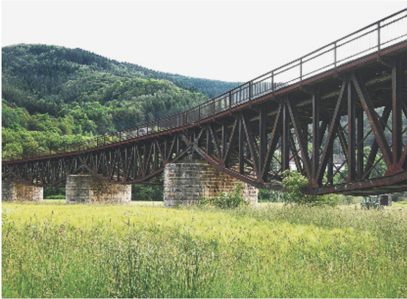
„Fischbauchträgerbrücke“ im Böddinghauser Feld. Foto: Christel Rautenberg, Stadt Plettenberg.
