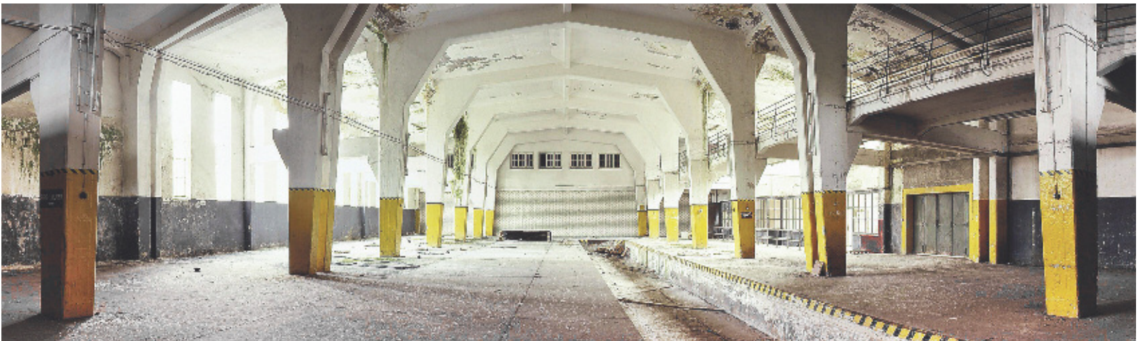
Zentrale Verladehalle. Fotos: Frank Wellenbrink, Bielefeld.
