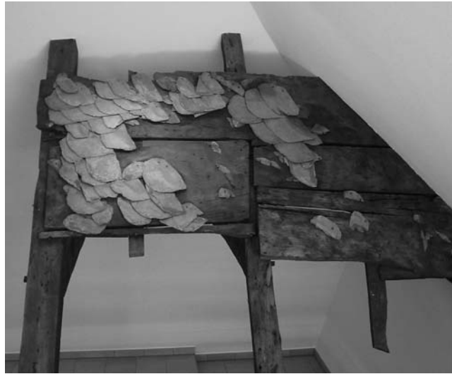
4 Erhaltene Dachdeckung von 1571. 2007.
