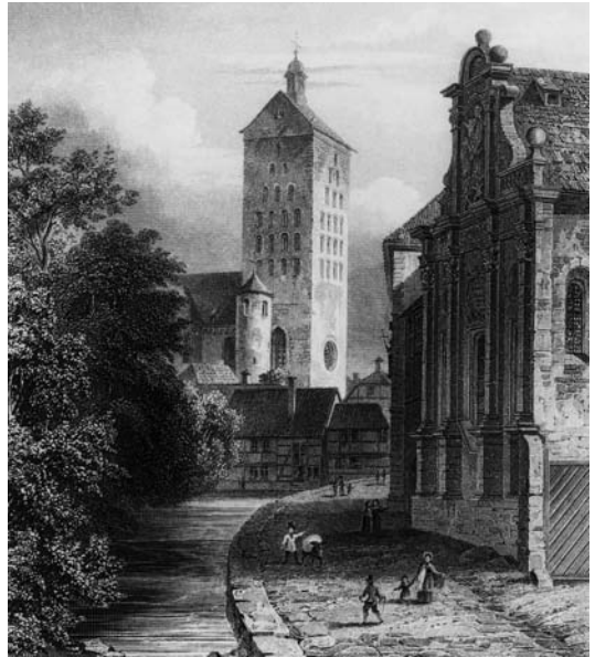
3 „Hauptquelle der Paderborn“, Stich um 1850, Domturm mit dem oberen Abschluss von 1815, den von Quast als erhebliche Beeinträchtigung des Denkmals bewertet hat.
