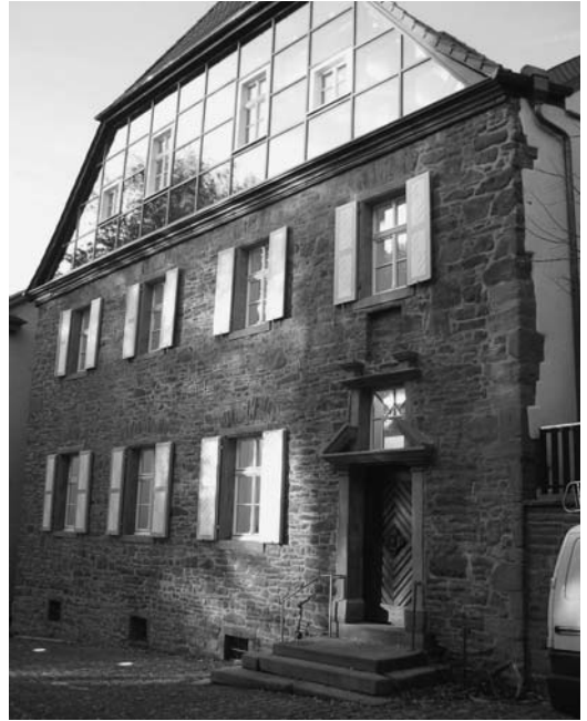
6 Ansicht des Gebäudes am Kirchplatz 4 nach der Sanierung.
