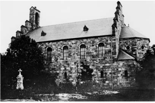
9 Ladbergen, ev. Kirche vor 1892 ohne Turm.
