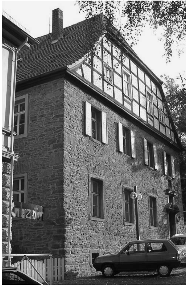
1 Ansicht der Fassade von 1715 vor der Sanierung. 2006.
