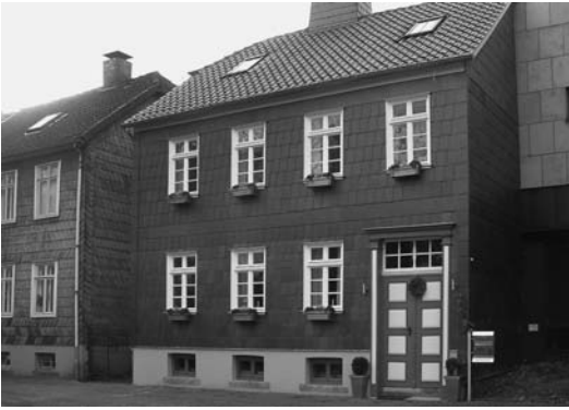
4 Denkmalgerecht saniertes Fachwerkhaus mit Schieferverkleidung und an der Wandaußenseite angebrachter Dämmung. 2007.
