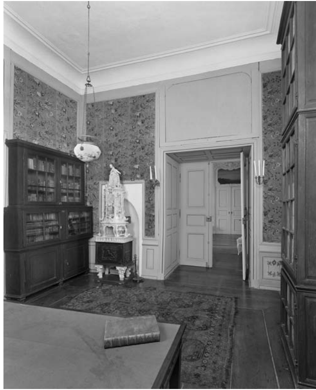
5 Schloss Hovestadt, Bibliothek nach Osten, Zustand nach der Restaurierung 2007.
