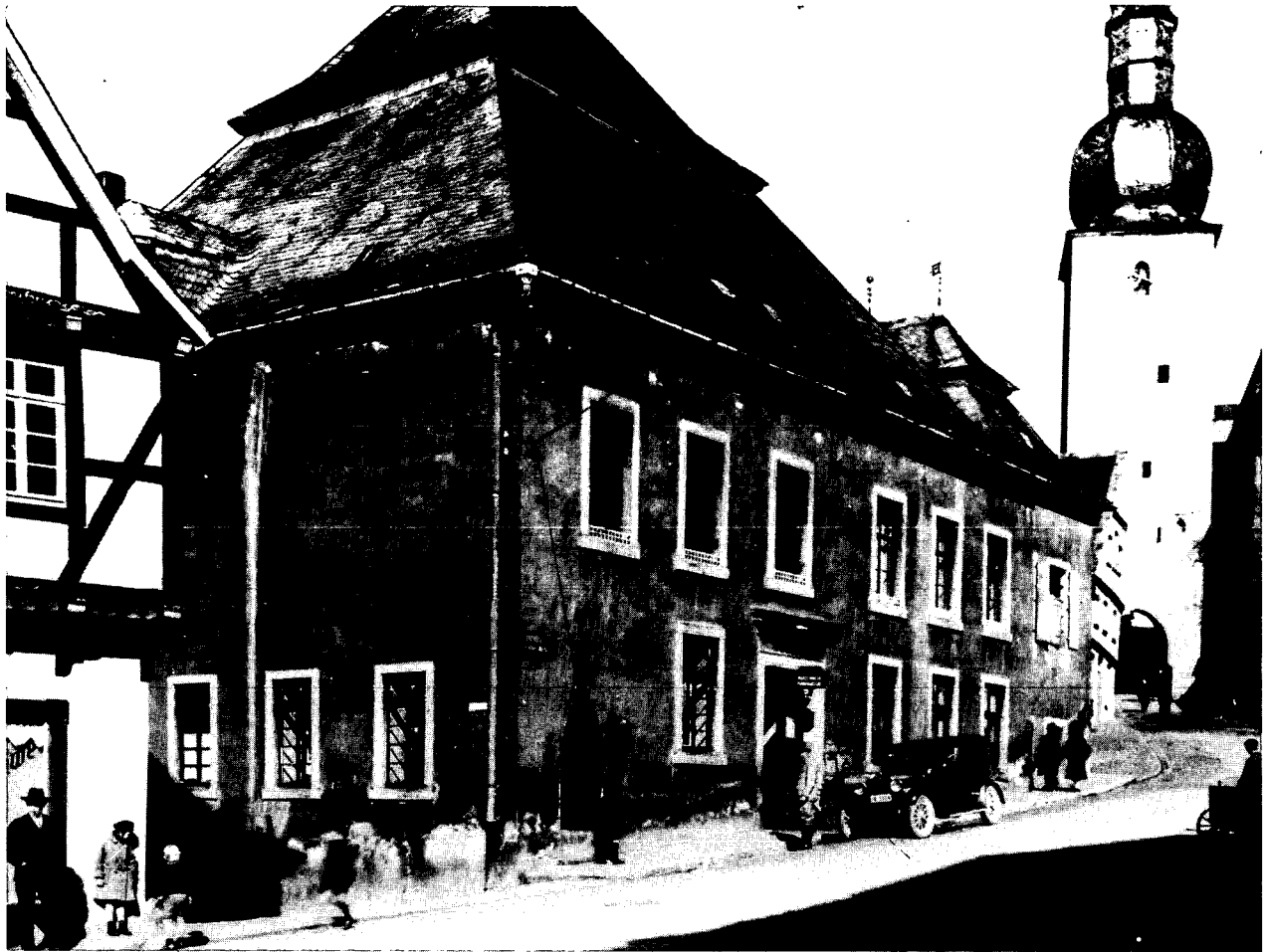
Abb. 8: Elektrische Straßenbeleuchtung in Arnsberg. Ende der 1920er Jahre (Foto: VEW-Archiv Dortmund)
