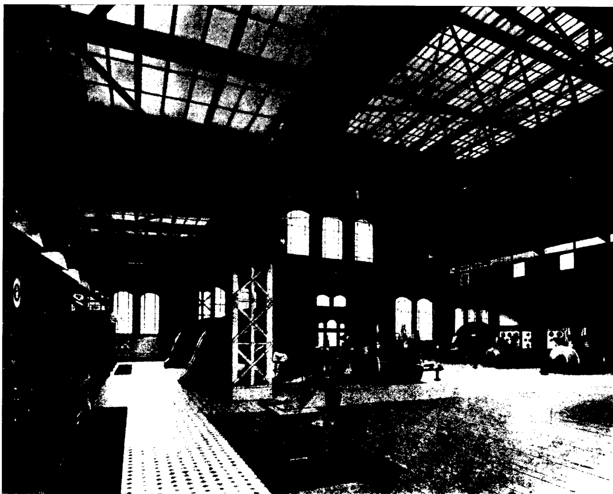
Abb. 1: Städtisches Elektrizitätswerk Dortmund. Maschinenhalle des Kraftwerkes an der Weißenburger Straße. Mit Drehstromgeneratoren (links) und Gleichstrom-Generatoren (rechts). 1897 (Aufnahme: VEW-Archiv Dortmund)
