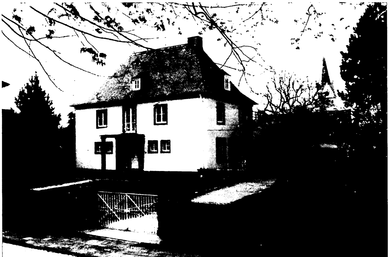
1. Villa in Geseke, Nordmauer. Architekt Prof. Otto Fiedering, Hannover 1936. (Westfälisches Amt für Denkmalpflege)
