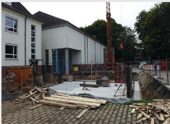
Westseite (Foto: LWL-Archivamt)
