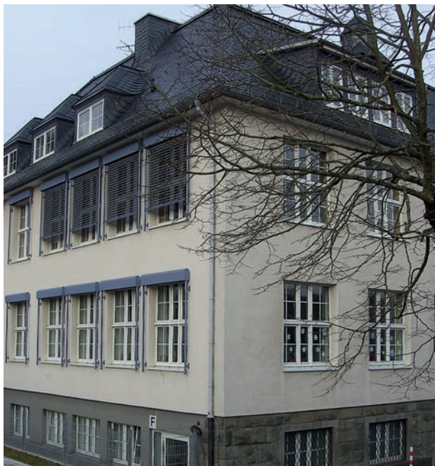
Abb. 1: Außenansicht des Gemeindearchivs im Parterre der Grundschule Burbach (Foto: Gemeindearchiv Burbach)
