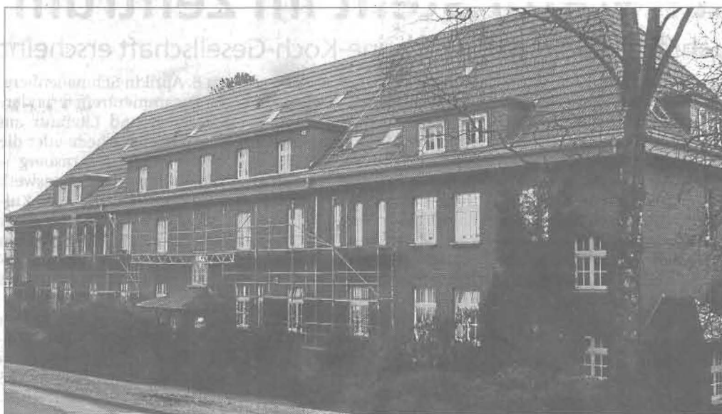
Das Haus 01 der LWL-Klinik Marsberg am Standort Bredelarer Straße 33 kommt jetzt wieder ohne Baugerüste aus. Neun Monate lang wurde hier umgebaut und renoviert.
