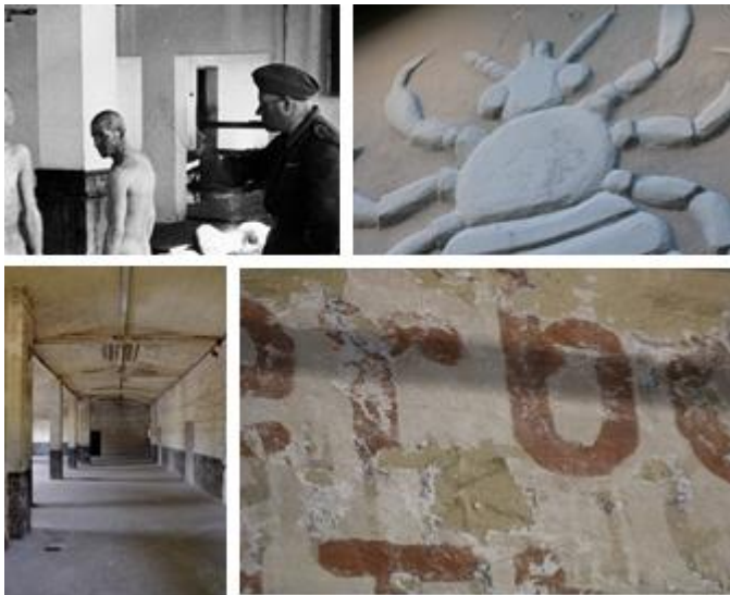
Aufnahme der „Entlausungsprozedur“ (1941) sowie aktueller Zustand des Entlausungsgebäudes: Gipslaus im Gebäudegiebel, Duschraum, „verboten“-Beschriftung (LWL/O. Nickel/J. Hecker)
