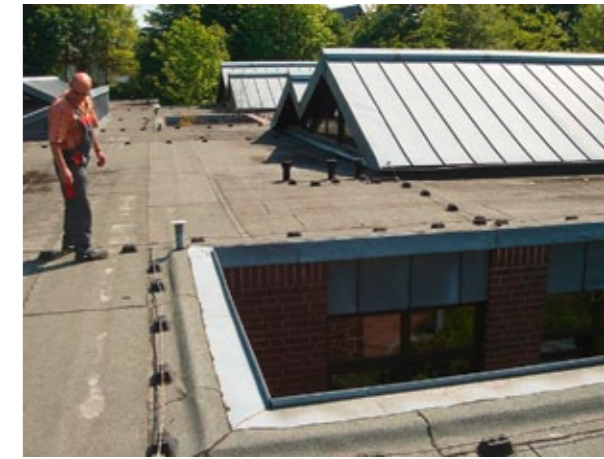
Flachdach des Kindergartens der LWL-Förderschule Bad Oeynhausen
