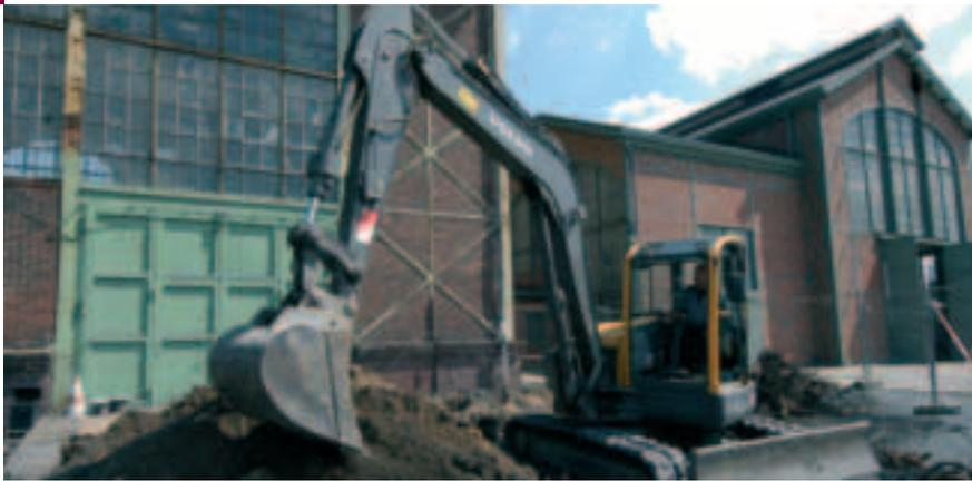
*Rund um die Maschinenhalle hob der Bagger einen Graben für die Drainage aus. Dabei wurden auch Reste alter Anbauten und Zugänge freigelegt.*
