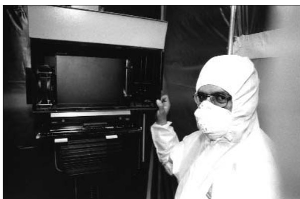
Während der Asbestsanierung im Fotolabor
