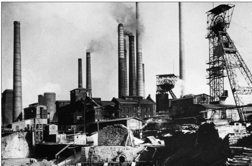
Trotz Strukturwandel – die vielen Industriebauten prägen nach wie vor das Gesicht des Ruhrgebiets. Das Foto aus den 1930er Jahren zeigt ein Zechengelände in Essen. Bildarchiv © LWL-Medienzentrum
