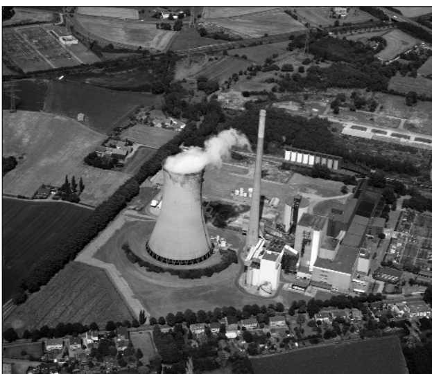
Steinkohlekraftwerk im Stadtteil Deininghausen in Castrop-Rauxel, 1993 Fotograf: Schwabenflugbild
