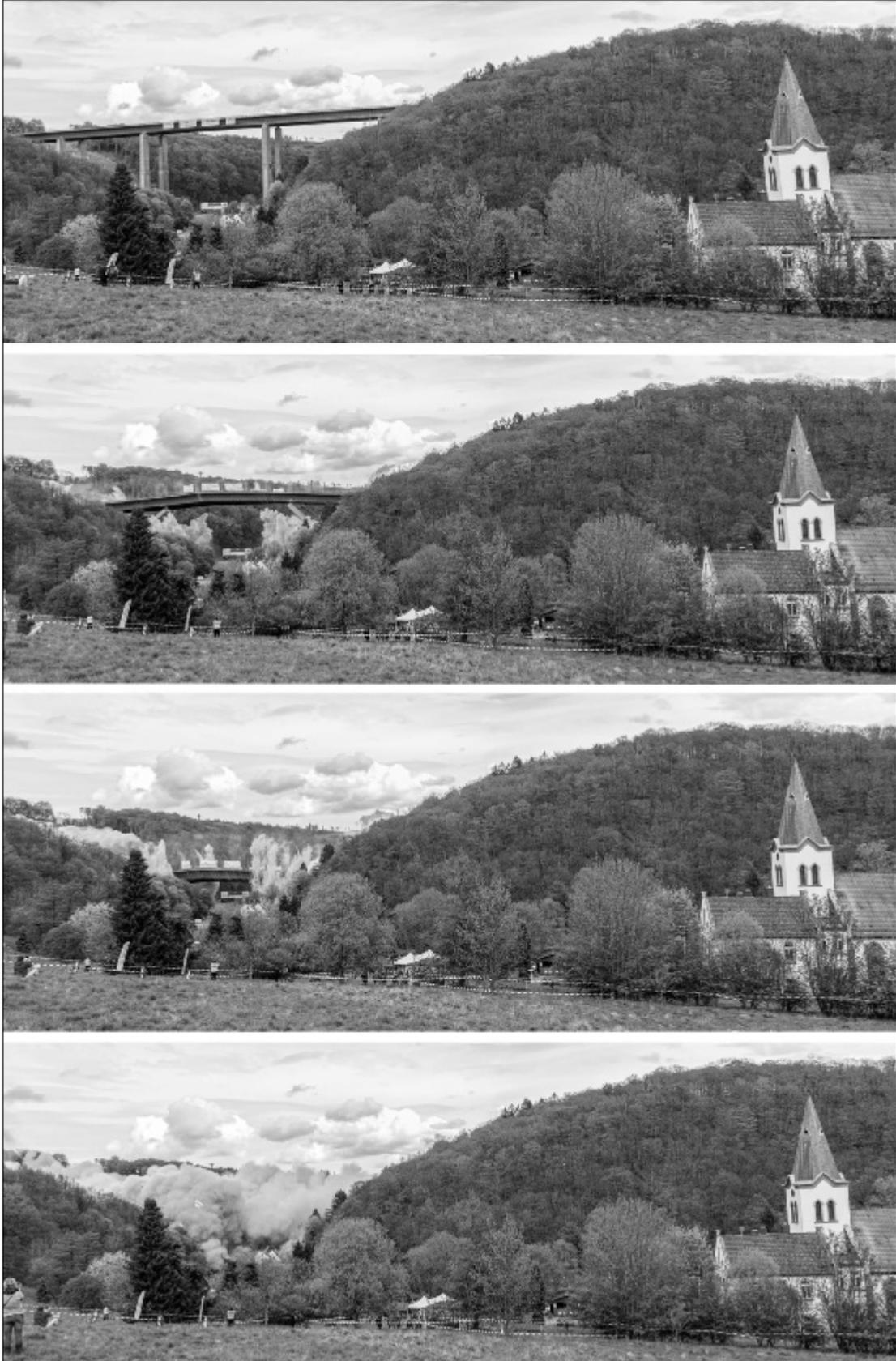
Fotoserie der Sprengung der A45-Talbrücke Rahmede Lüdenscheid
