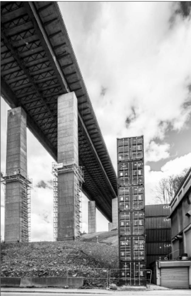
Unterhalb der Talbrücke Rahmede, mit Sand und Wasser gefüllte See-Container zum Schutz der umliegenden Gebäude.
