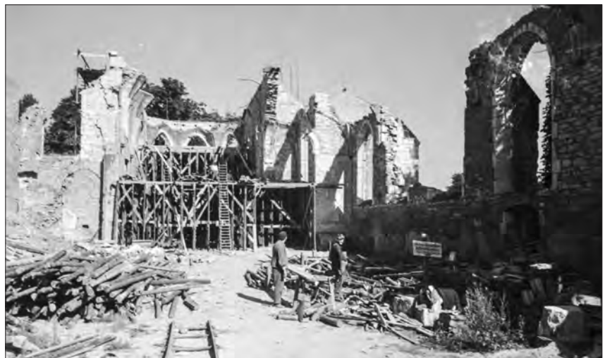
Wiederaufbauarbeiten an der kath. St. Agneskirche, Hamm, um 1947.
