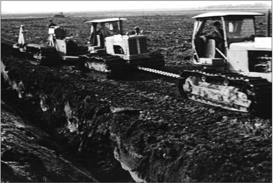
Bis zu fünf Raupenschlepper ziehen den Pflug, mit dem der Boden bis zu 1,60 m Tiefe aufgerissen und Sand- sowie Torfschichten miteinander vermischt werden. Ende der 1950er Jahre. Standbild aus dem Film.
