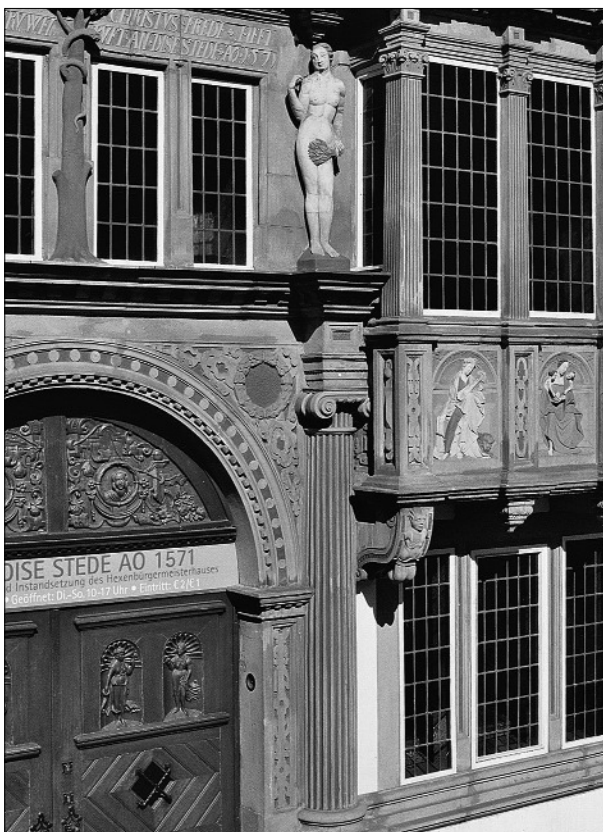
Details an der reich verzierten Fassade des Hexenbürgermeisterhauses
