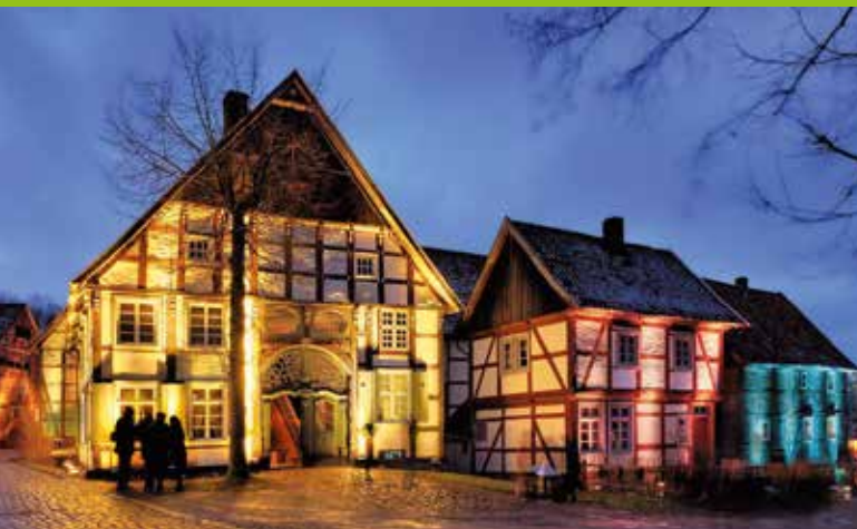
Drei nebeneinander stehende Fachwerkhäuser sind in farbiges Licht getaucht.
