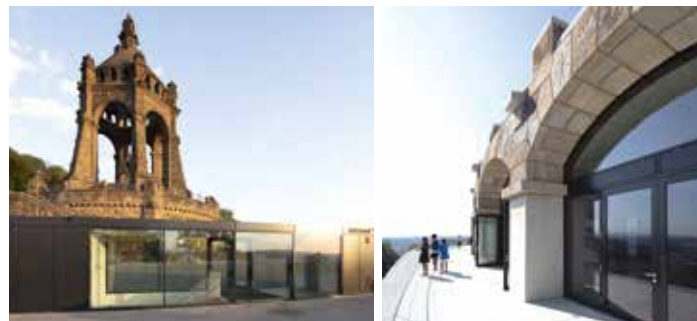
Das Besucherzentrum, Terrasse.
