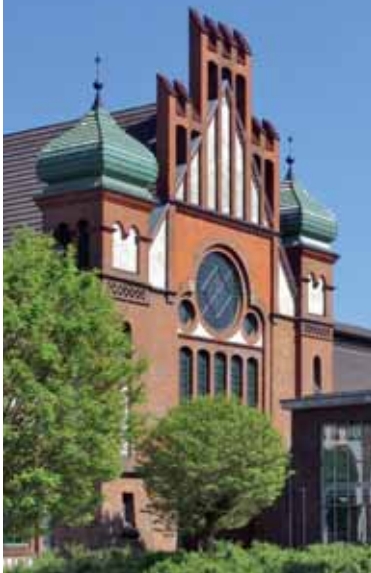
Fassade der Lohnhalle.
