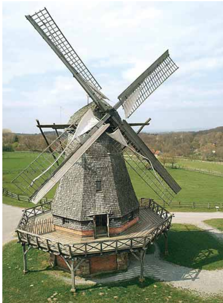
Anders als bei der älteren Bockwindmühle muss bei dieser Technik aus Holland nicht mehr das gesamte Gebäude in den Wind gedreht werden.
