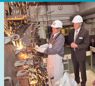
Beim Abriss der alten Heizkessel legte LWL-Direktor Dr. Wolfgang Kirsch mit dem Schneidbrenner selbst Hand an – hier assistiert vom Kaufmännischen Direktor Helmut S. Ullrich. (Foto: Soester Anzeiger)
