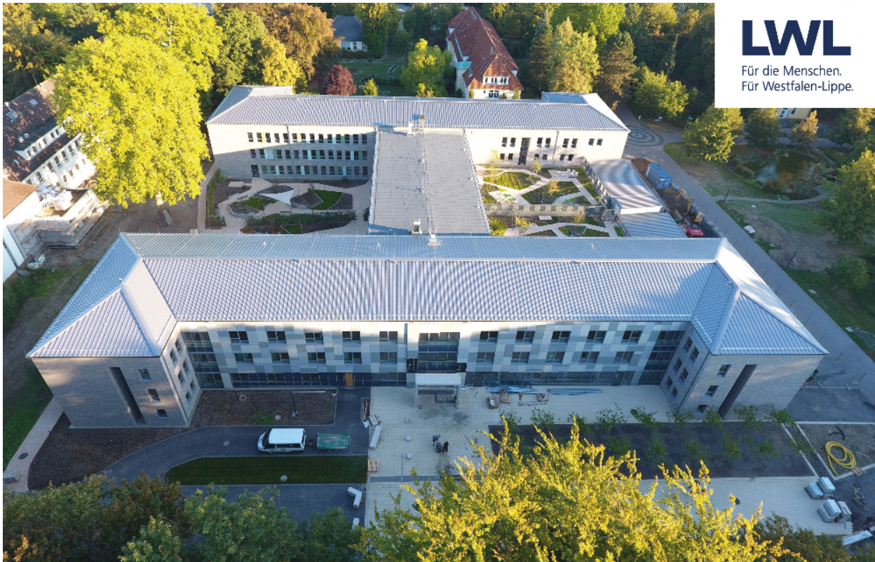
Das neue Hauptgebäude der LWL-Klinik Münster
