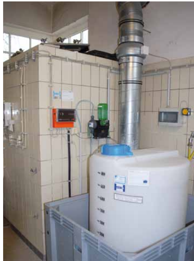
Einblick in das Wasserwerk auf dem Klinikgelände.
