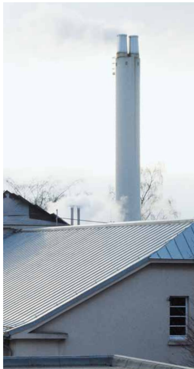
Kesselhaus des Blockheizkraftwerks.
