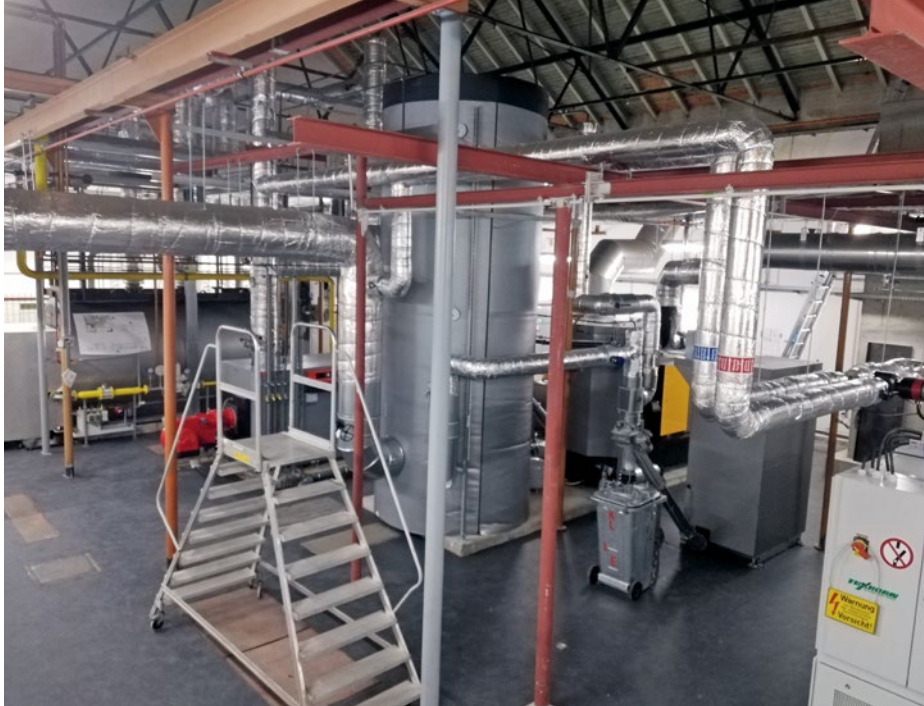
Ein Blick in die technische Zentrale: Hier wurde ein neuer Erdgasbrennwertkessel, ein Holzpelletkessel und ein neues Blockheizkraftwerk installiert.
