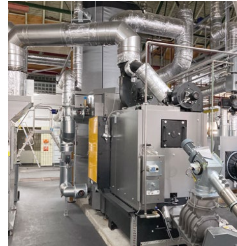
Der neue Holzpelletkessel mit Wärmespeicher.
