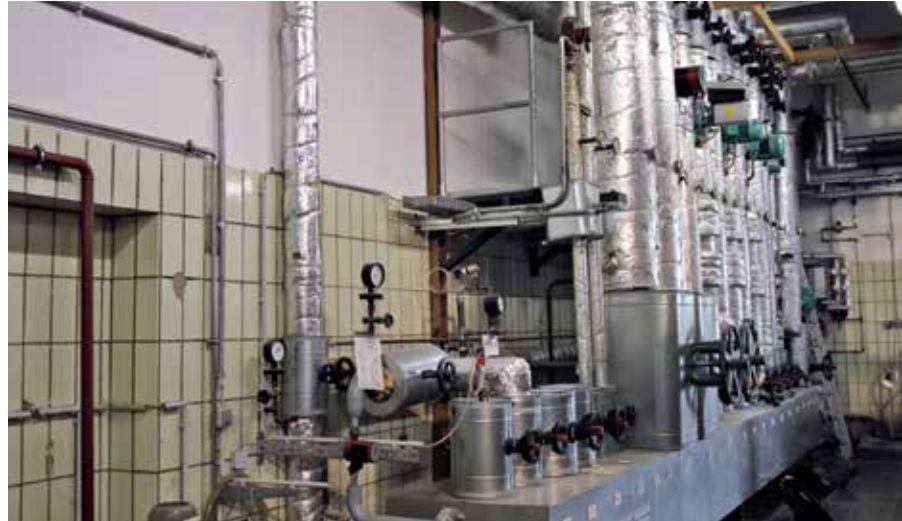
Zentrale Wärmeverteilung
