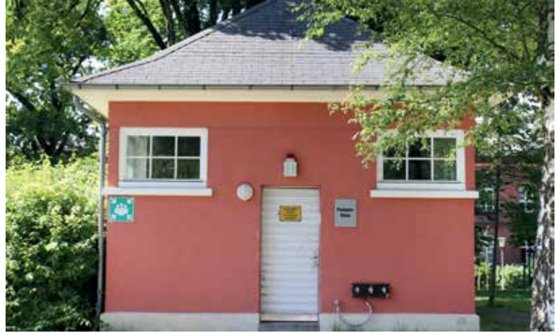
Das Pumpenhaus unseres Wasserwerkes auf dem Klinikgelände.
