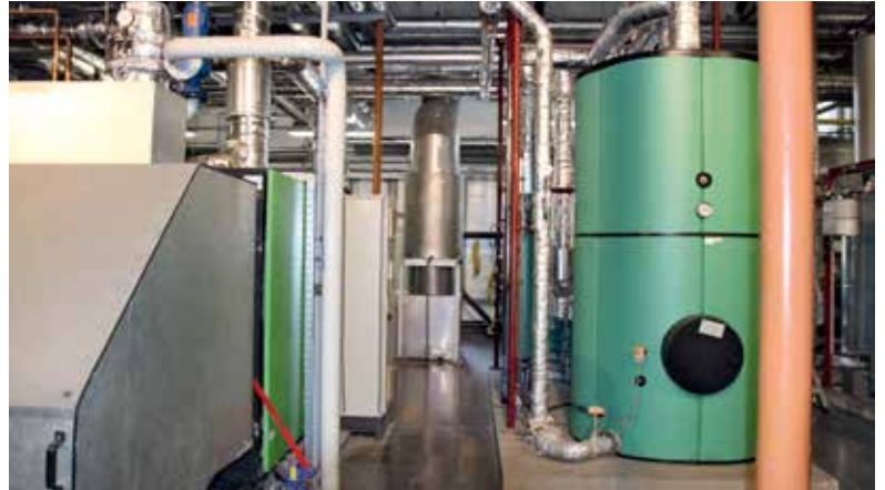
Einblick in das Kesselhaus
