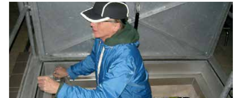
Die Energiebeauftragten besichtigen das Pumpenhaus auf dem Klinikgelände und werden über die Trinkwasserversorgung der Klinik informiert.
