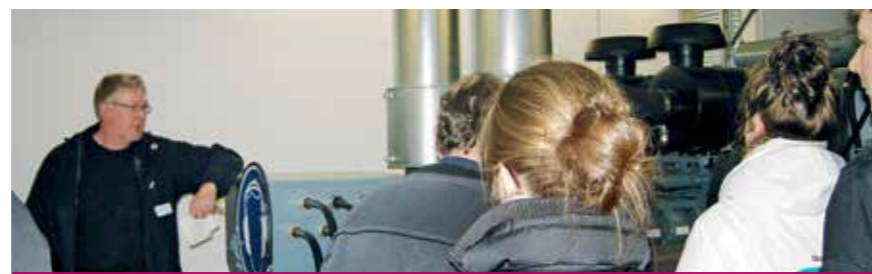
Die Energiebeauftragten besichtigten das Kesselhaus und wurden über die Energieversorgung in der Klinik informiert.
