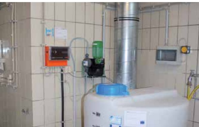
Einblick in das Wasserwerk auf dem Klinikgelände.
