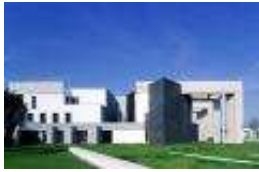
Nieuwbouw van de synagoge van Duisburg, 1998.
