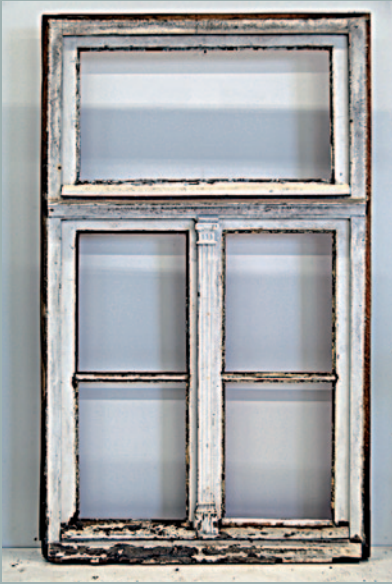
Fenster im umgebauten Zustand (1908): zwei Flügel und Kippoberlicht.
