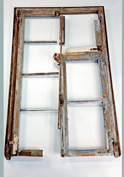
Montage während der Restaurierung: links ursprünglicher Zustand (1877), rechts umgebauter Zustand (1908).
