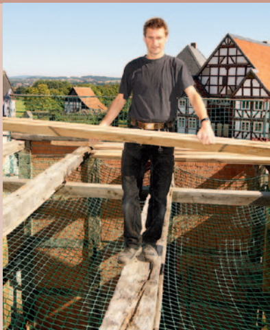
Sicherheit ist oberstes Gebot. Vor dem Aufbringen des Eichenfußbodens wurden Auffangnetze unter die Balkenlage gespannt. Jetzt kann sich Burkhard Gemke als Akrobat üben.
