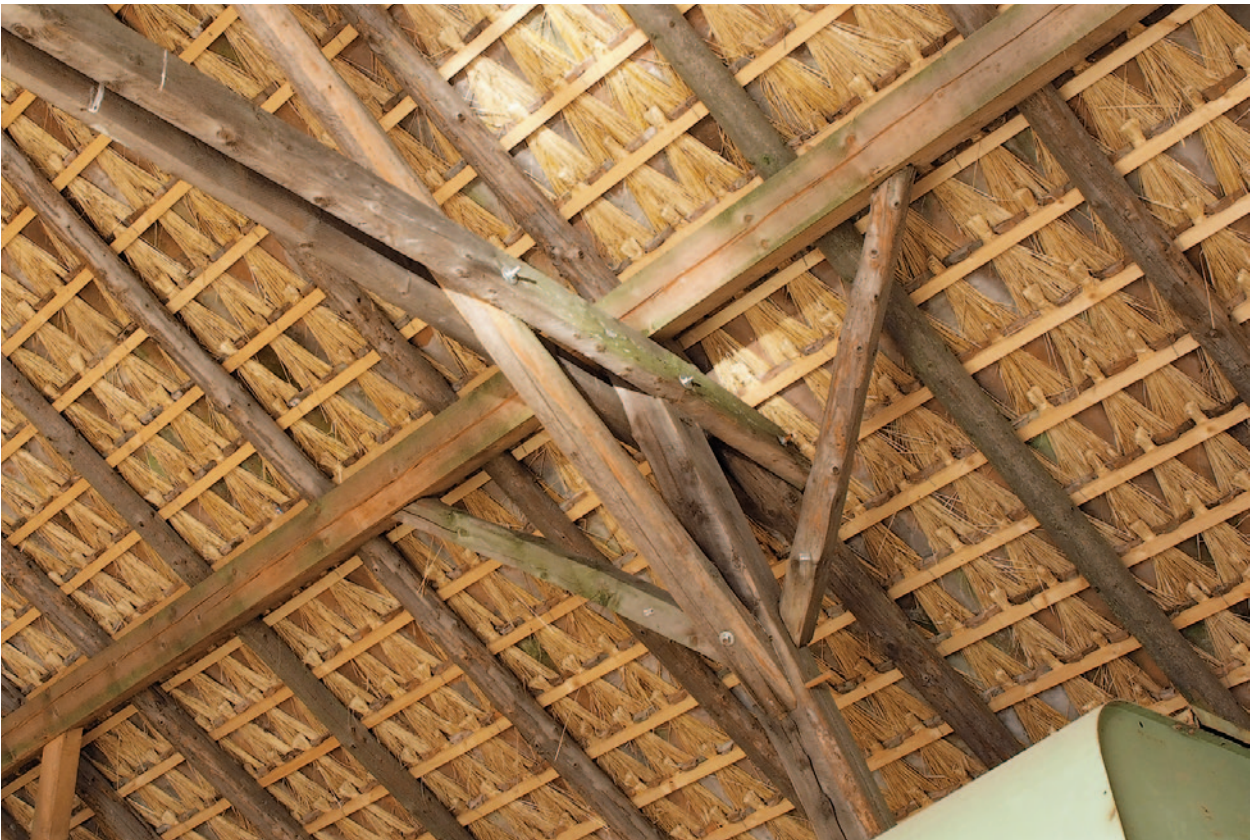
Blick auf den Gefügeknoten von Mittelpfette, Doppelzange und Strumstrebe im historisch erhaltenen Teil der Feldscheune aus Stapelage.
