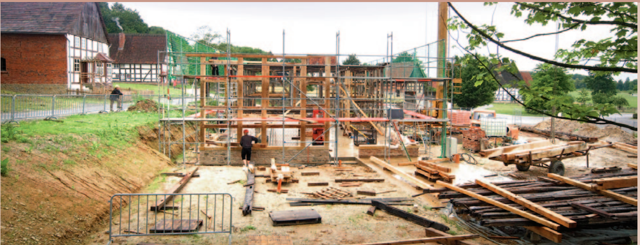
Bevor das Dach aufgesetzt wird, muss der Fachwerk-Hauskasten durch Ausmauerung stabilisiert werden. Rechtes Bild: Zur Stabilisierung gehört auch der Eichenfußboden auf der Hauptbalkenlage. Claudia Diekmann, Jan Leymann, Hubertus Michels und Christian Fuß (v. li.) bei der Vorbesprechung der Arbeiten am 14. August 2008.
