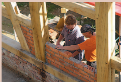
Bevor das Dach aufgesetzt wird, muss der Fachwerk-Hauskasten durch Ausmauerung stabilisiert werden. Rechtes Bild: Zur Stabilisierung gehört auch der Eichenfußboden auf der Hauptbalkenlage. Claudia Diekmann, Jan Leymann, Hubertus Michels und Christian Fuß (v. li.) bei der Vorbesprechung der Arbeiten am 14. August 2008.
