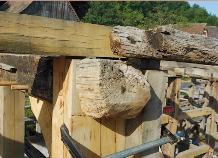
Das Ergebnis fachgerechter Restaurierung. Ein wiederhergestellter Gefügeknoten mit originalen und ergänzten Konstruktionsanteilen. Rechts: Das Richten ist Teamarbeit. Konzentration und Koordination sind gefordert, wenn mehrere Gefügeknotenpunkte gleichzeitig hergestellt werden.
