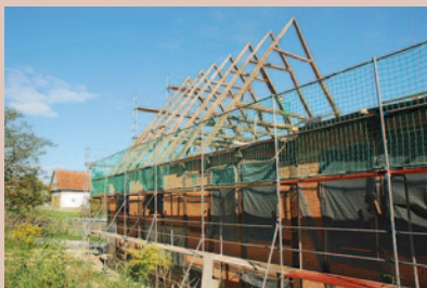
19. September 2008. Die Hälfte des Daches steht. Jetzt sieht es schon aus wie ein richtiges Haus.
