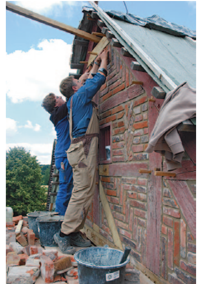
Instandsetzung des Giebels am Haus Golücke.
