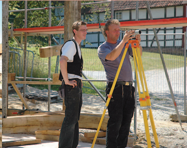
Die ersten Fachwerkwände stehen. Jürgen Kagerer (re.) und Jan Leymann (li.) bei der Höhenkontrolle mit dem Nivelliergerät.
