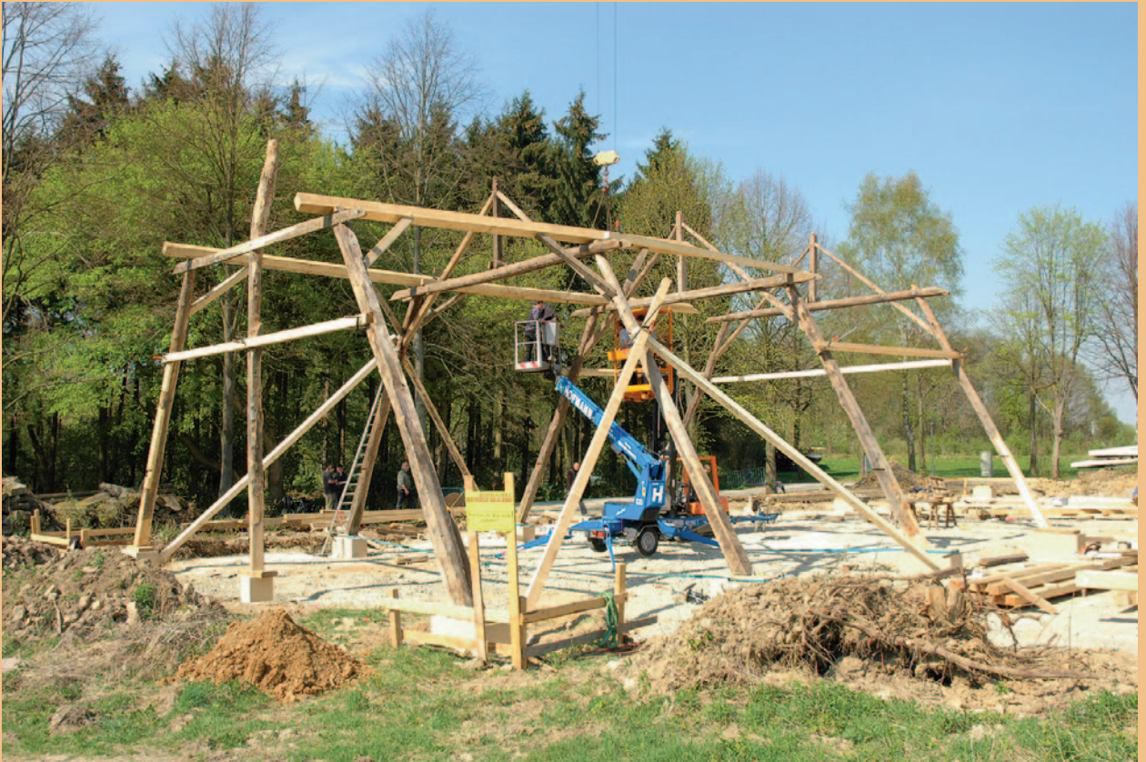
Richtarbeiten an der Feldscheune aus Stapelage im April 2007 durch Schüler der Fachschule für Baudenkmalpflege und Altbauerhaltung Detmold.
