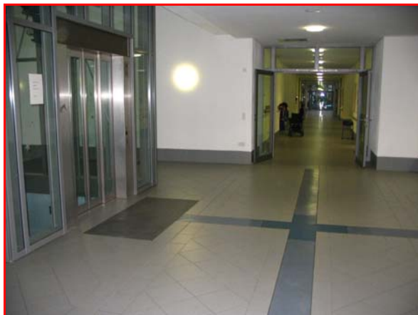
Kontrastierter Leitstreifen mit Noppenfeld-Kreuzung für Türbereiche und Achtung-Zone vor dem Aufzug
