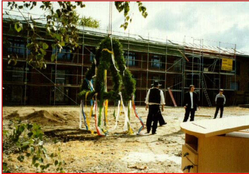
Unser neues Schulgebäude im Rohbau - Richtfest am 4.9.2000
