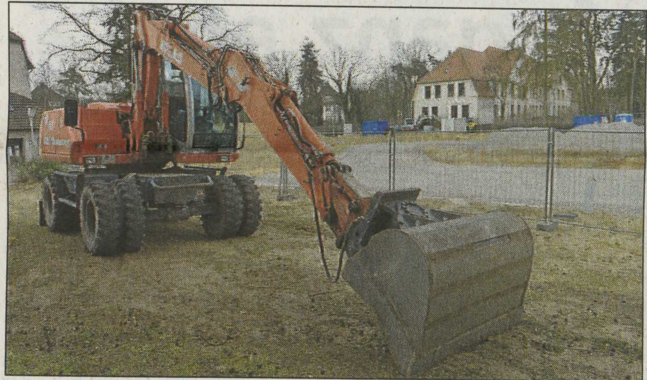
Einsatzbereit, aber unbesetzt. Sobald es wärmer wird, soll dieser Bagger die Grundlage des neuen Parkdecks schaffen. Foto: Carsten Borgmeier
