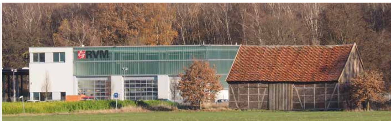
Ein Standort mit ungewisser Zukunft: Mäusepfeilerscheune im Gewerbegebiet Lüdinghausen-Tetekum
