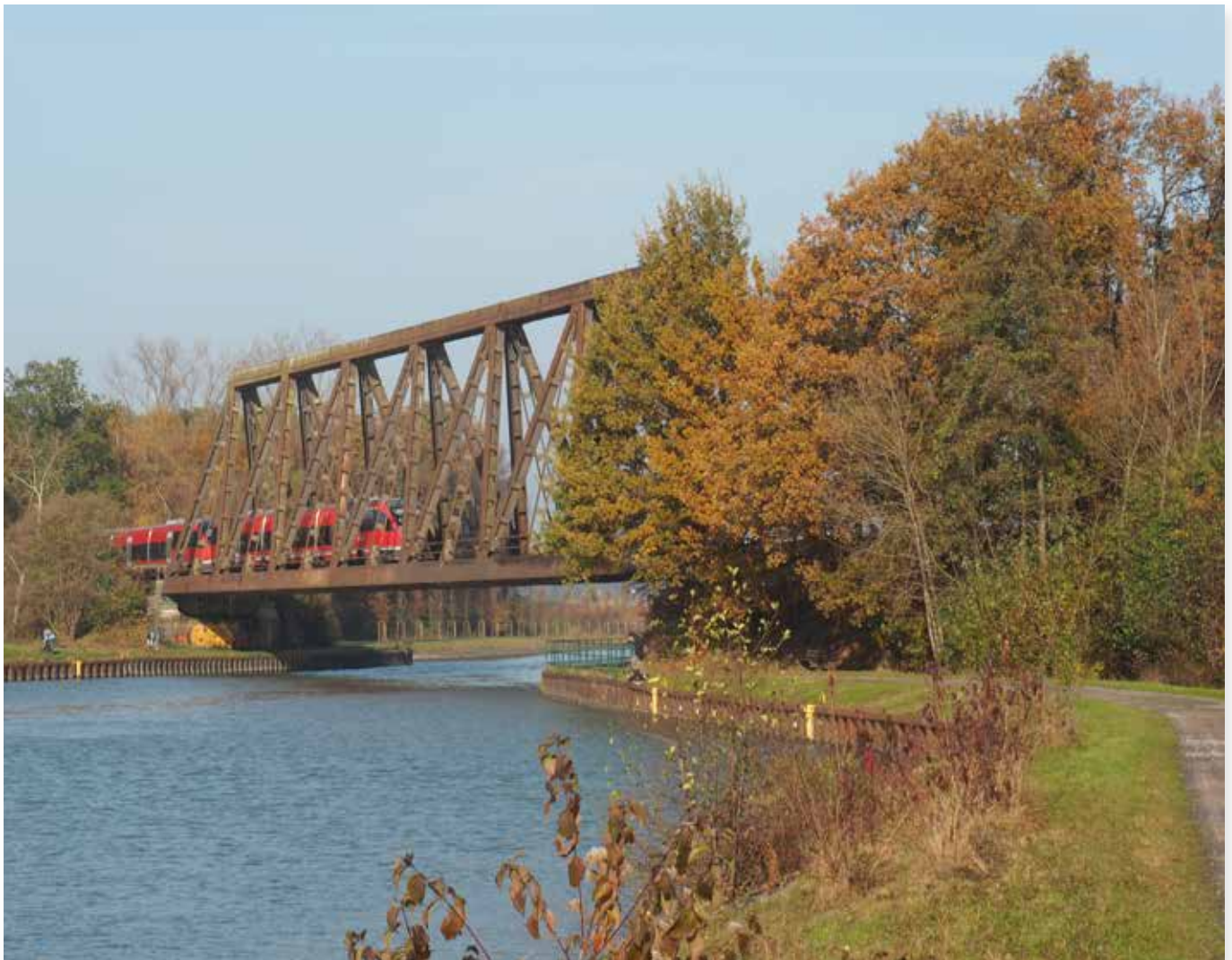
Stattliche 105 Meter lang und doch zu kurz für den neuen Dortmund-Ems-Kanal: die denkmalgeschützte Eisenbahnbrücke Lüdinghausen (1937)
