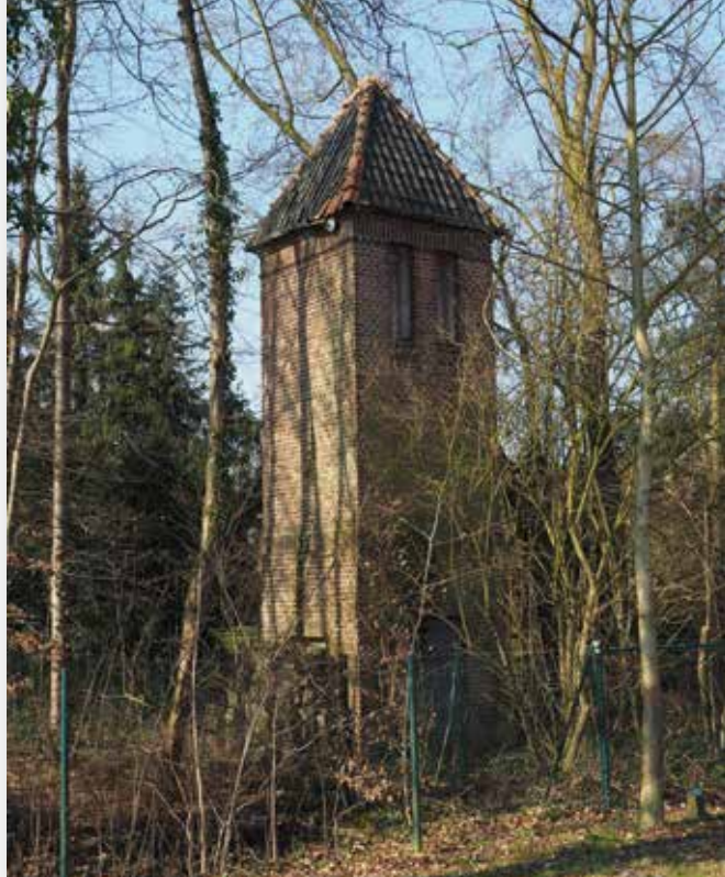
Ins Abseits gestellt: Trafoturm im Schlosspark Nordkirchen
