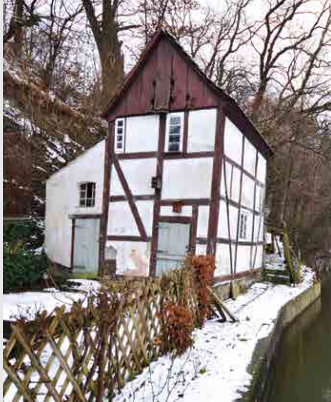
Der Kleine Speicher am Westergraben vor Beginn des Rückbaus und nach der Ausmauerung der Gefache. Fotos: Michael Sprenger (li.), Kultur- und Heimatverein Badulikum (re.)
