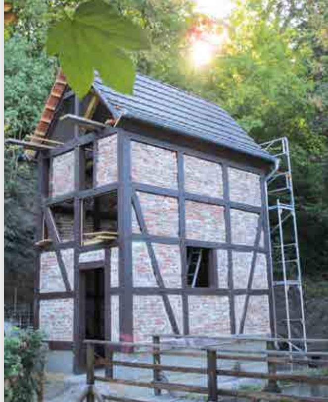
Der Kleine Speicher am Westergraben vor Beginn des Rückbaus und nach der Ausmauerung der Gefache. Fotos: Michael Sprenger (li.), Kultur- und Heimatverein Badulikum (re.)
