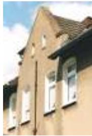
Kleines Zwerchhaus in Ziegelmauerwerk mit den gleichen Zierelementen des Haupthauses
