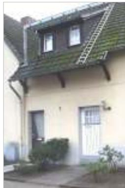
*Vordach integriert durch größeren Dachüberstand im Bereich der Haustüren.*
