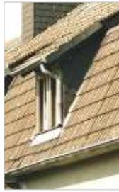
Schleppgauben auf Sattel- und Mansarddach mit Schieferverkleidung
