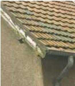
Ursprünglicher Abschluss mittels Ortgang- und Deckbrett (Windbrett oder "Windfeder")
