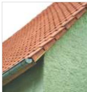
Einfacher Abschluss mittels profilierter Ortgangpfannen vor einem Streichbrett oder -sparren (bei größeren Dachüberständen) oder auch direkt vor der aufgehenden Wand
