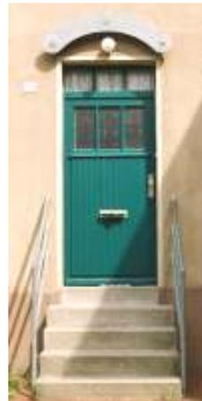
*Betonblockstufen und Geländer in ursprünglicher Form erneuert*
