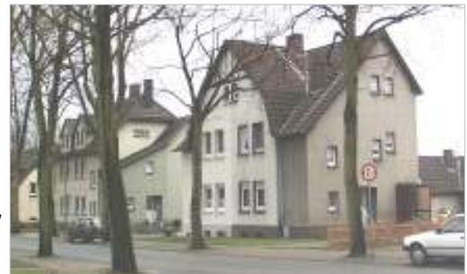
Die Beamtenhäuser sind bezüglich ihrer Außenwandmaterialien vielfältiger gestaltet. Sie zeigen entweder eine Putz-Ziegel-Kombination oder Putzfassaden, die mit Gesimsen versehen sind. Nur bei wenigen, kleineren Wandflächen wie z.B. in den Giebelspitzen wird Fachwerk oder eine Holzschalung als Gestaltelement eingesetzt.
