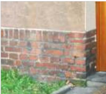
*Ursprünglicher Mauerwerkssockel mit Rollschicht*
