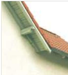
Putzbau mit großen Dachüberständen an Ortgang und Traufe (Sparren- und Pfettenköpfe geformt)
