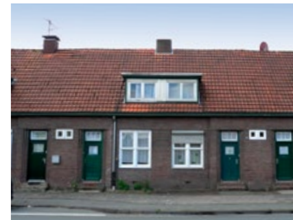
Textilarbeitersiedlung, Gronau // Foto: LWL/M. Philipps
