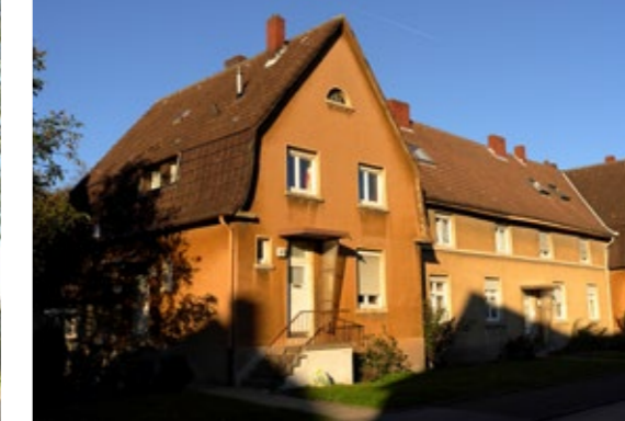
Arbeitersiedlung, Ahlen // Foto: LWL/M. Philipps
