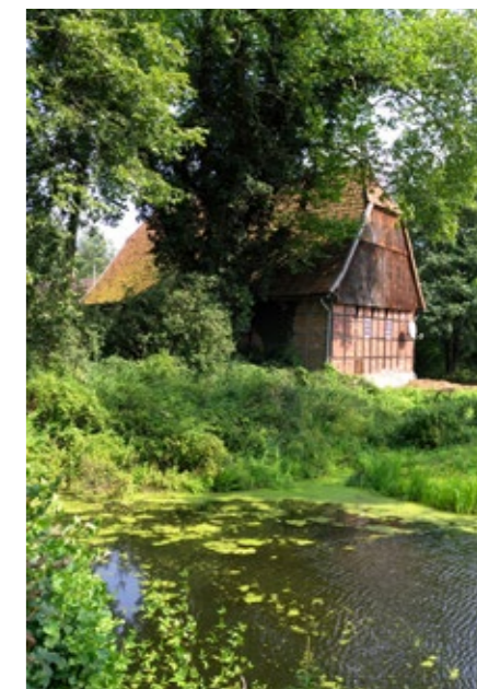
Mühle von Haus Langen, Westbevern // Foto: LWL/M. Philipps
