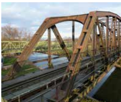
Brücke Wandhofen in Schwerte // Foto: LWL
