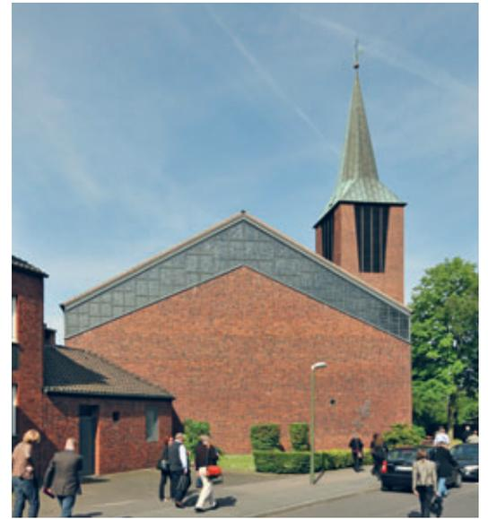
Der schlichte, rechteckige Baukörper ist mit Mauerwerk aus roten, hart gebrannten Klinkern errichtet. Der Innenraum wird durch ein umlaufendes Fensterband unmittelbar unter der Fläche des Satteldachs belichtet. Ursprünglich war es – der Einfachheit des Raumkonzepts entsprechend – klar verglast. Heute sind von Max Ingrand gestaltete Buntfenster eingesetzt, die zum gedämpften Raumcharakter beitragen.
