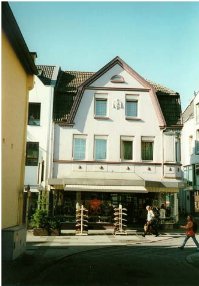
Das Mansard-Dach mit hineingestelltem Zwerchgiebel nimmt die Giebelständigkeit der Nachbargebäude auf (Abb. links).
