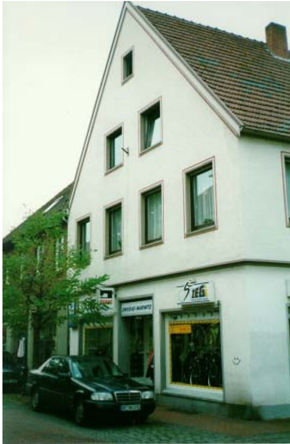
Schlichtes giebelständiges Gebäude mit Satteldach und einfachem Dreiecks-Giebel mit Ortgang-Abschluß durch Windbord
