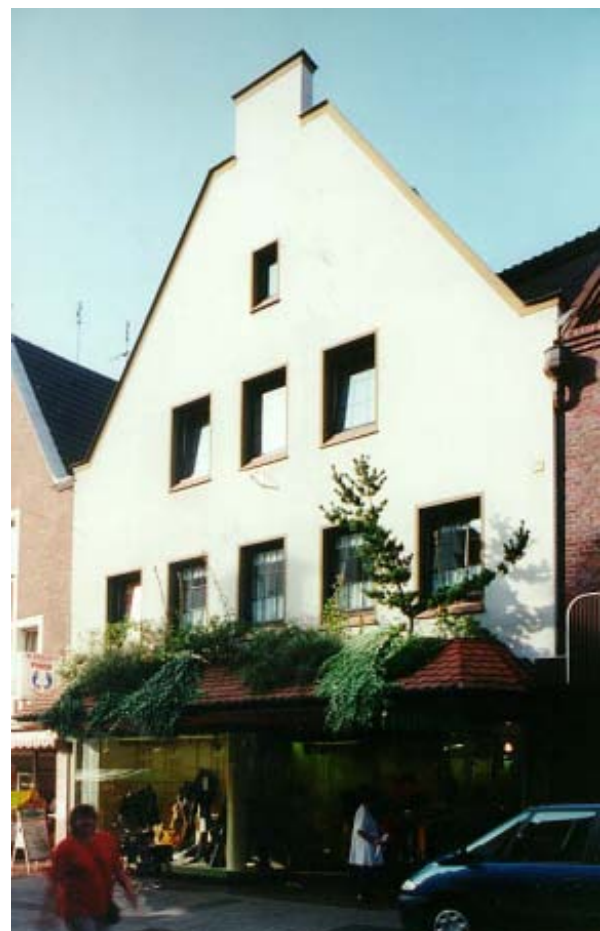
Breite mehrgeschossige giebelständige Gebäude in den Hauptstraßen.
