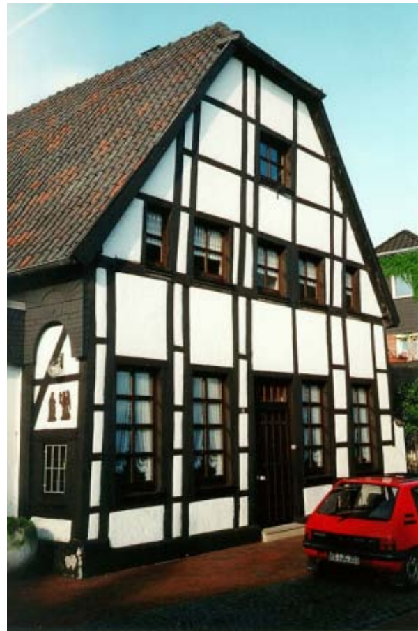
Giebelständiges Fachwerkgebäude mit Viertelwalm ("Krüppelwalm") und mit Ortgang-Abschluß durch typisches Windbord
