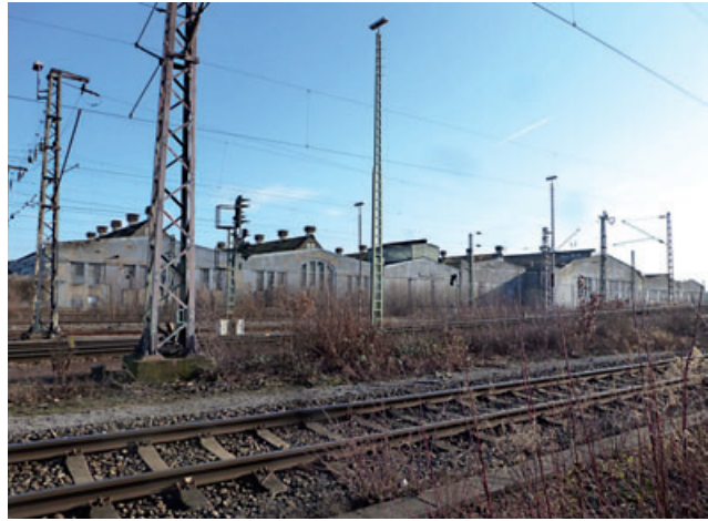
3 Westansicht des Personenzuglokschuppens von 2017.
