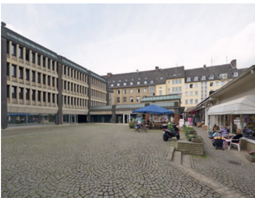
1 Blick in den Rathausinnenhof auf den Erweiterungsbau des historischen Rathauses am Scharn, der inzwischen weitgehend abgebrochen wurde. Foto 2016.
