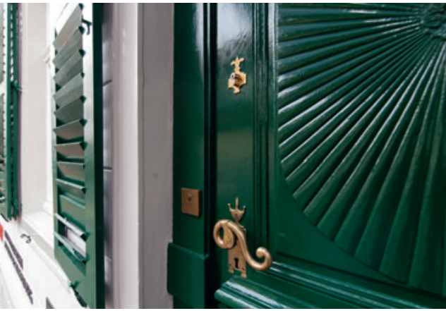
8 Detail der restaurierten Eingangstür an der Hauptseite des Gebäudes zum Markt.
