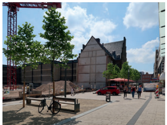
2 Blick vom Scharn in den Rathausinnenhof nach den Abbrucharbeiten im Sommer 2018.
