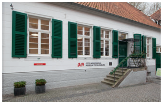
10 Das OMMT – Otto Modersohn Museum Tecklenburg, Ansicht des Gebäudes vom Markt aus im Dezember 2015 nach der Eröffnung.
