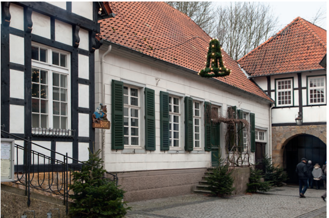
4 Ansicht der Marktseite des Gebäudes im Vorzustand Ende 2014. Links des Gebäudes befand sich ehemals das Wohnhaus des Amtsrichters Wilhelm Modersohn, rechts bzw. nördlich anschließend an Markt 9 die sogenannte Stadtlegge, die ehemalige Leinenprüfstelle, mit dem Torhaus.
