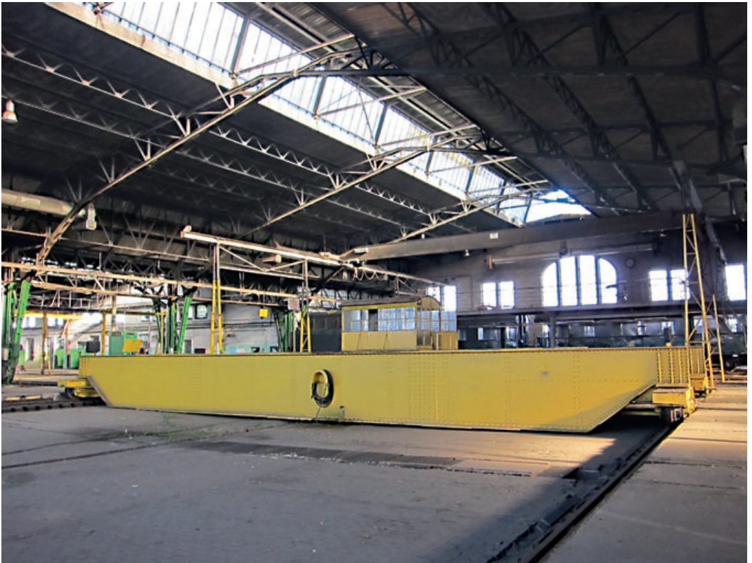
4 Innenansicht des Personenzuglokschuppens mit Schiebebühne von 2017.
