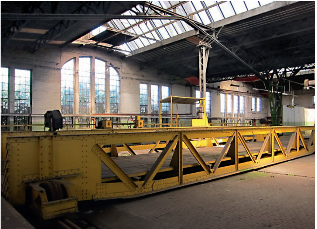
5 Innenansicht des Personenzuglokschuppens mit Schiebebühne von 2017.
