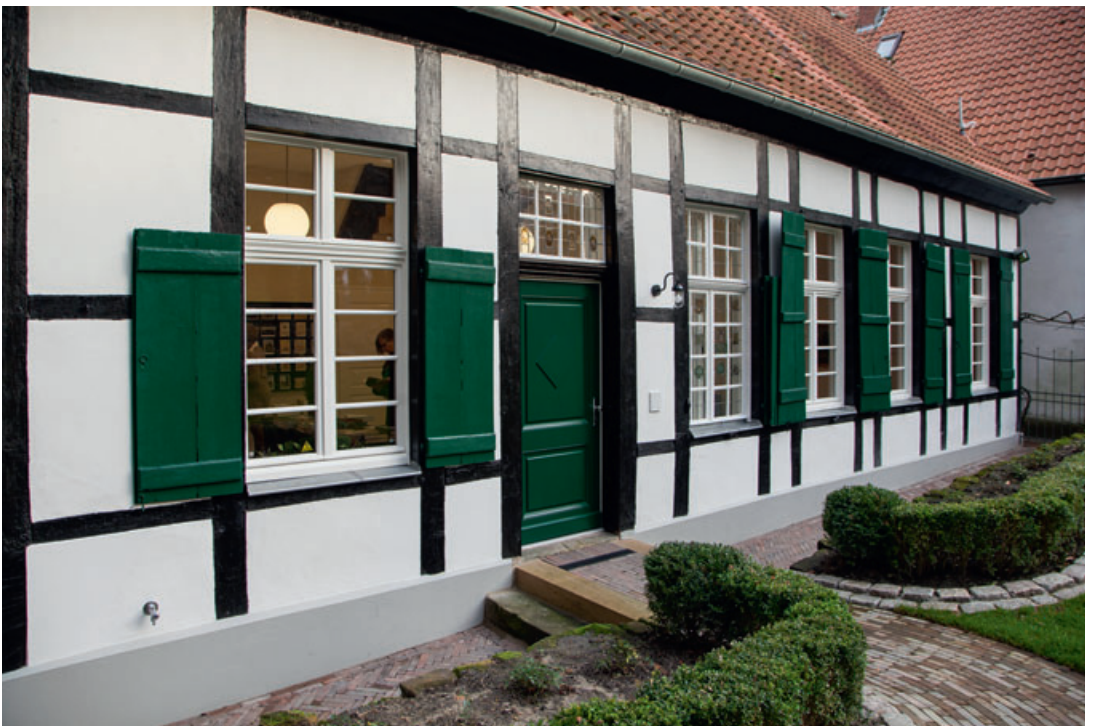
1 Ansicht der Gartenseite des Hauses 2015; die beiden nachträglich aufgesetzten Dachgauben wurden bei der Sanierung entfernt.
