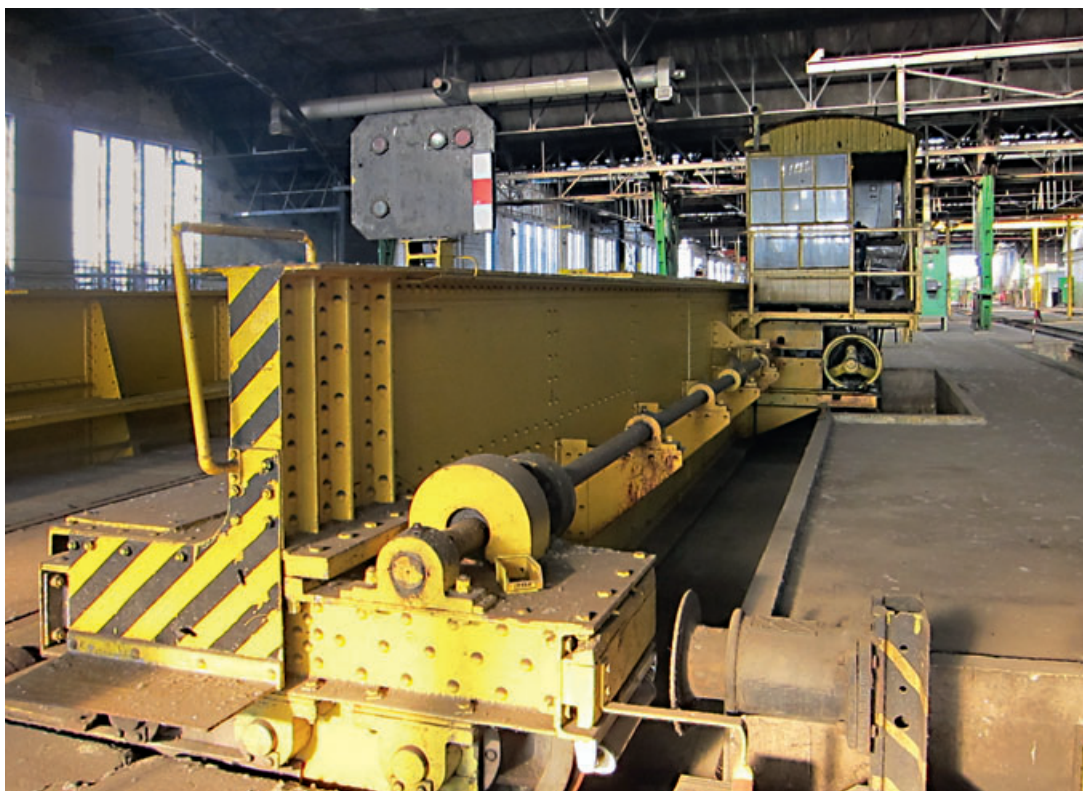
8 Detail der Schiebebühne, Foto von 2017.
