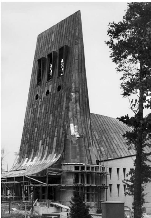
5 Raumfachwerkkonstruktion mit Kupferverkleidung, zwischen 1963 und 1966.
