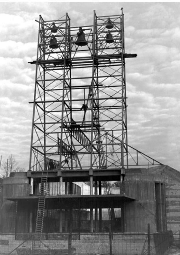
4 Raumfachwerkkonstruktion des Turmes und Betongusswände, zwischen 1963 und 1966.
