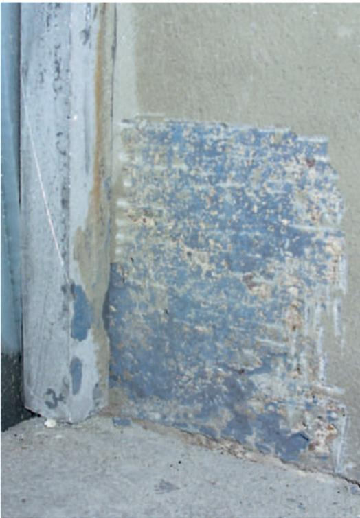
20 Farbbefund der Erstfassung außen am Betonstrebenwerk, 2018.
