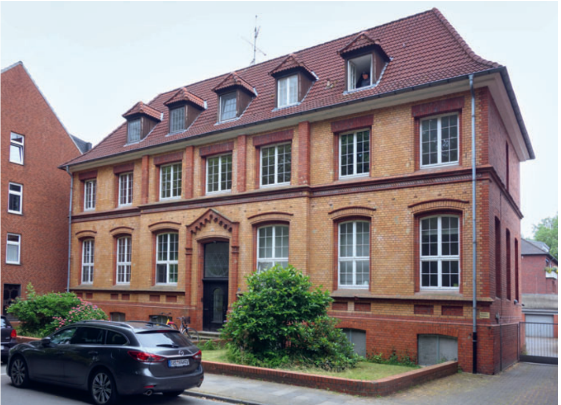
4 Münster, Am Kanonengraben 4, das Gebäude der Marks-Haindorf-Stiftung. Foto 2021.
