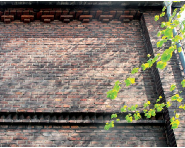
5 Unverputztes bauzeitliches Mauerwerk an der Südwestwand des Hauses. Foto 2021.
