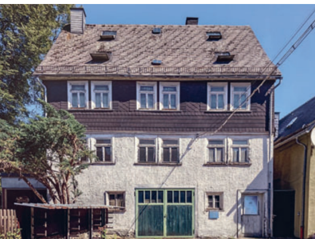
11 Synagoge Bad Laasphe (Kreis Siegen-Wittgenstein) von 1764, nach Umbau 1939 zum Wohnhaus mit Werkstatt. Zustand 2019.
