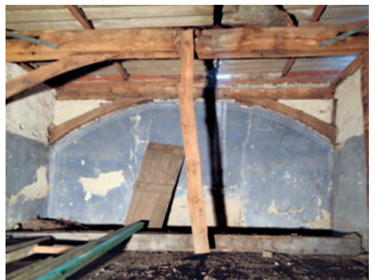
8 Synagoge in Telgte; Blick auf die Ostwand mit der erhaltenen Ausmalung, der Konstruktion der Tonnendecke und der vermauerten Thora-Nische. Zustand 2019.
