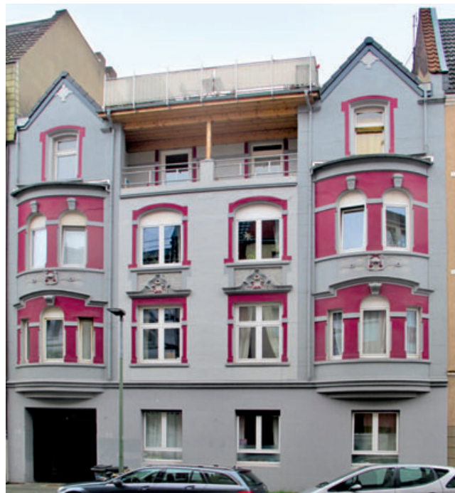
6 Bochum, Wohn- und Geschäftshaus, erbaut um 1905, ab 1907 Pferdehandlung eines jüdischen Händlers, 1943 erst Ghettohaus, dann enteignet, bei der Ablehnung der Eintragung 1990 wegen der veränderten Fassade war die jüdische Geschichte unbekannt. Foto 2021.
