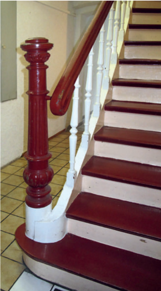
7 Treppe im Erdgeschoss. Foto 2021.
