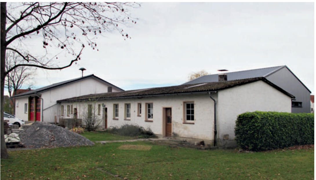
3 Büren, Wewelsburg, Küchen- und Kantinenbaracke des KZ Niederhagen, Baudenkmal seit 2017. Foto 2016.
