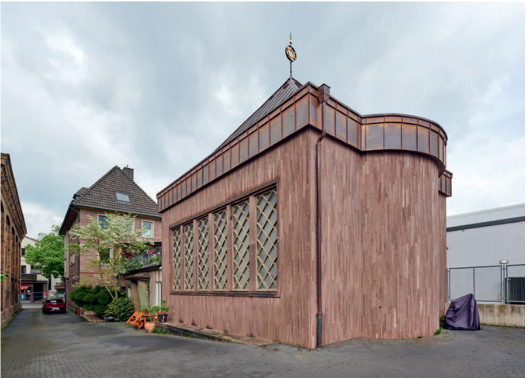
2 Synagoge mit Verbindungsbau und Wohnhaus. Foto 2021.
