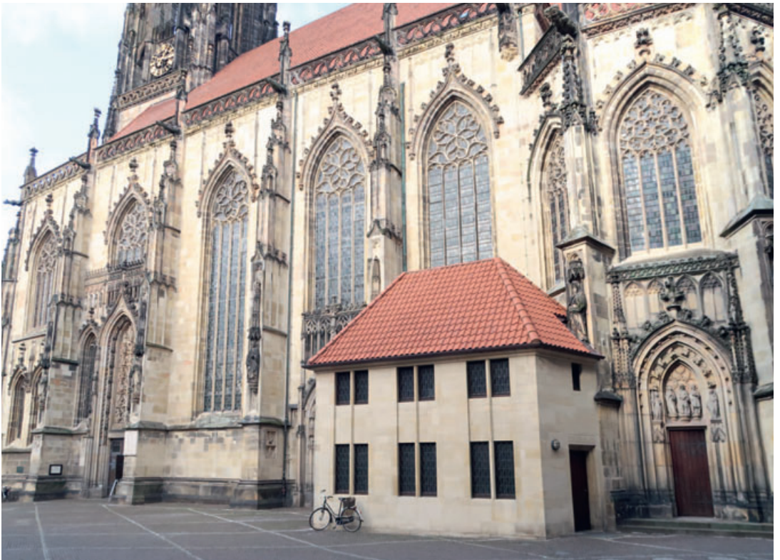
3 Südfassade der St. Lambertikirche. Foto 2021.
