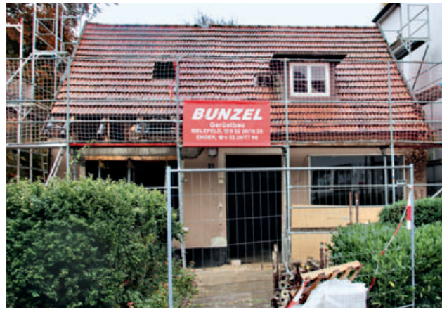
4 Westfalen. 1870 erbaut, ab 1909 koschere Schlachtereierie, 1942 Ghettohaus, Entkernung 2019, kein Baudenkmal. Das Foto illustriert den Standpunkt, dass das Haus wegen seiner durchgreifenden Veränderung keine Aussagekraft mehr habe. Foto 2019.
