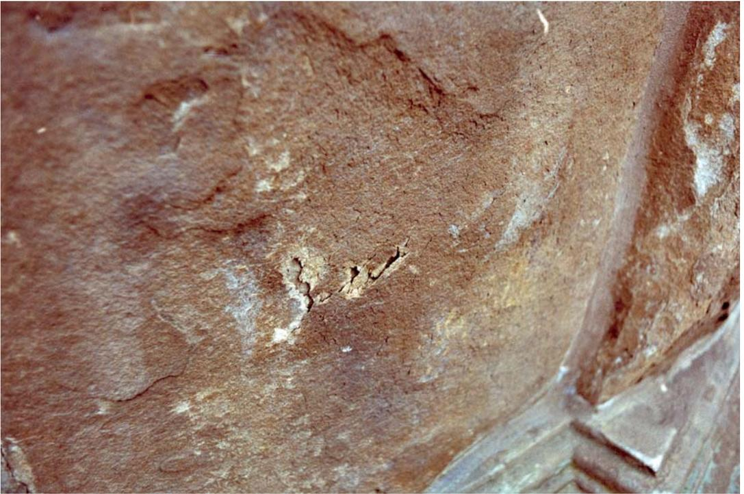
5 Detail einer Blasenbildung am Stein. Die verdichtete Oberfläche wird abgedrückt, das Steinmaterial darunter ist mürbe und sandend. Es sind Salzkristallisationen zu erkennen. Foto 1996.
