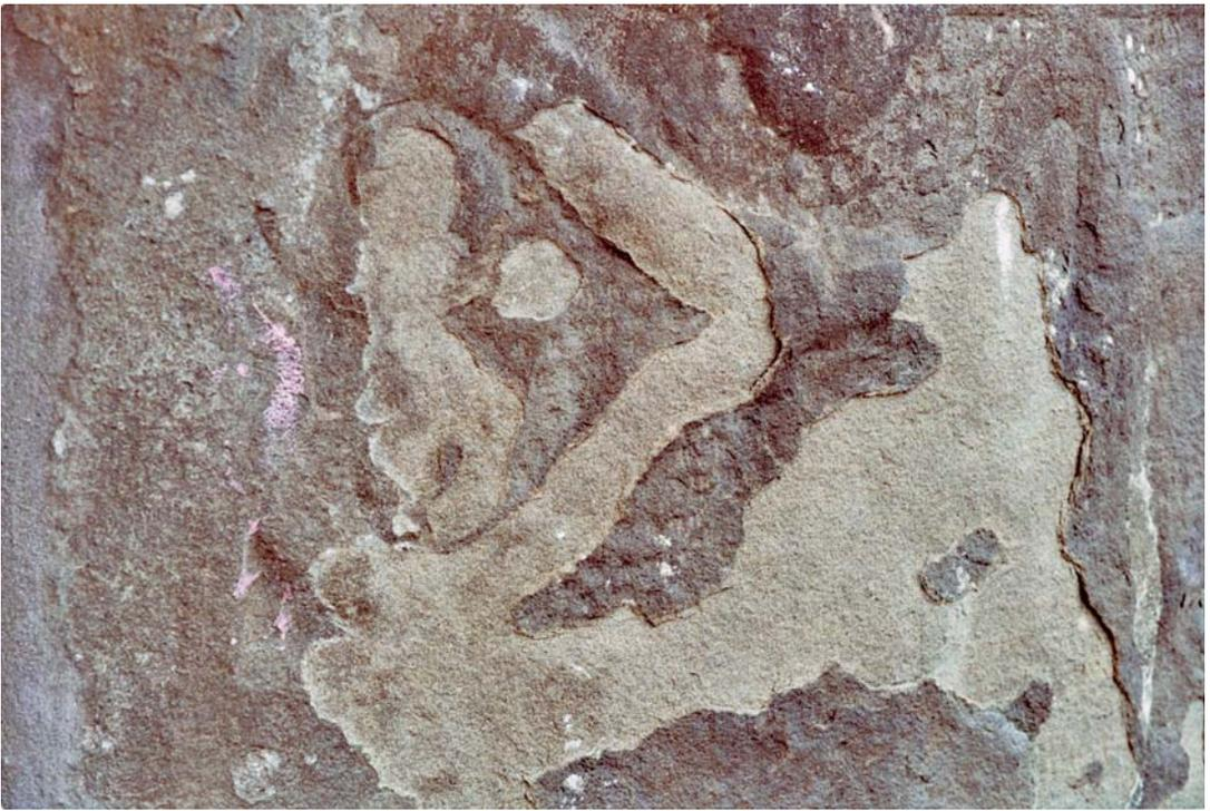
4 Detail der verdichteten und vergrauten Oberfläche. In den helleren Bereichen ist der Putz bereits abgeplatzt.
