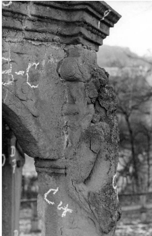
3 Gut zu erkennen ist an den originalen Hermenpfeilern die oberflächenparallele Riss- und Schalenbildung. Foto 1963.
