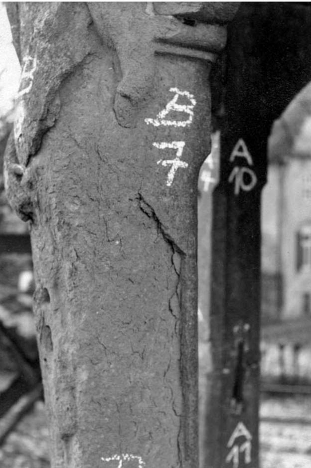
2 Die Schäden an den originalen Hermenpfeilern. Die Oberfläche ist bereits weitgehend verloren. Foto 1963.
