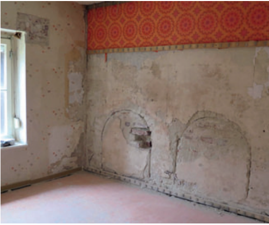
8 Südwestlicher Obergeschossraum. Sondagen zeigen die beiden südlichen, 1939/40 zugesetzten Rundbogenfenster, die durch den damaligen Einbau der Geschosdecke unten gekürzt erscheinen; links oben eine Sondage am straßenseitigen, vormals rundbogigen Fenster. Foto 2018.
