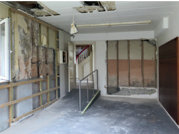
6 Nordöstlicher Teil des Hauptraumes mit Blick in den Eingangsflur nach Teilabnahme nachträglicher Verkleidungen der Wände und der 1939/40 eingezogenen Decke; rechts eine ebenfalls später eingefügte Trennwand. Foto 2018.
