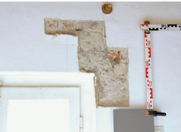
9 Sondage am oberen Abschluss des südwestlichen Treppenhaufensters; der gerade Abschluss wurde durch einen 1939/40 eingebauten Betonsturz hergestellt. Foto 2017.
