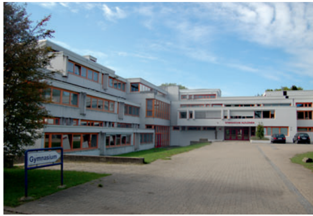
8 Haupteingang des Gymnasiums Lünen-Altünen, 1968–73. Einer von mehreren Schulbauten des Architekten Harald Deilmann. Foto 2013.
