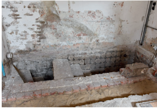
10 Ehemalige Mikwe; links die ältere, im Bauvorgang verworfene Treppenlösung, dementsprechend ohne Fliesen, rechts die Stufen zu dem in Nutzung gewesenen kleineren Becken mit erkennbarem Fliesenmörtel. Unten im Bild der Mörtelabdruck des einstigen Banketts zur Beckenbegrenzung. Foto 2018.
