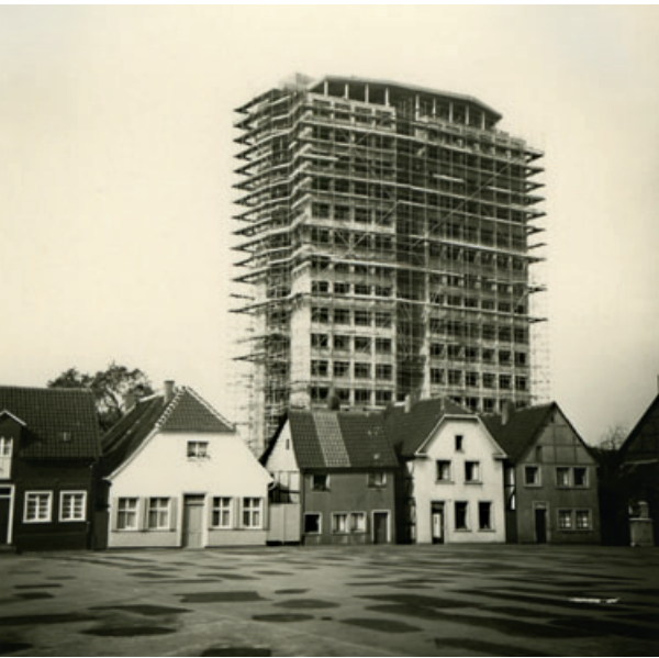
2 Impuls zur baulichen Erneuerung: Der Rathausneubau von 1956–1960 setzt sich bewusst von der historischen Bebauung am Markt ab, die kurze Zeit später abgerissen wird. Foto aus der Bauzeit 1958.
