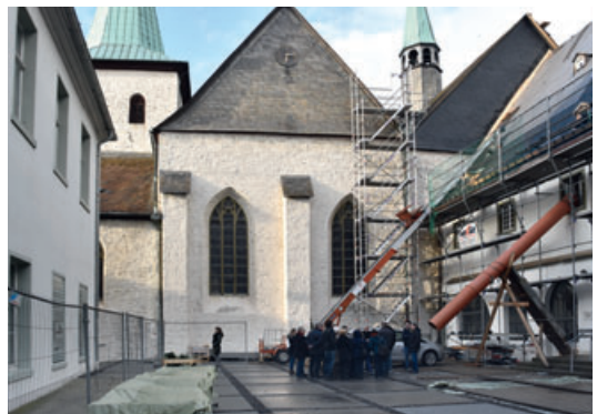
3 Die Veranstaltungen geben Einblicke in aktuelle Baumaßnahmen, wie hier im Kloster Wedinghausen. Foto 2017.
