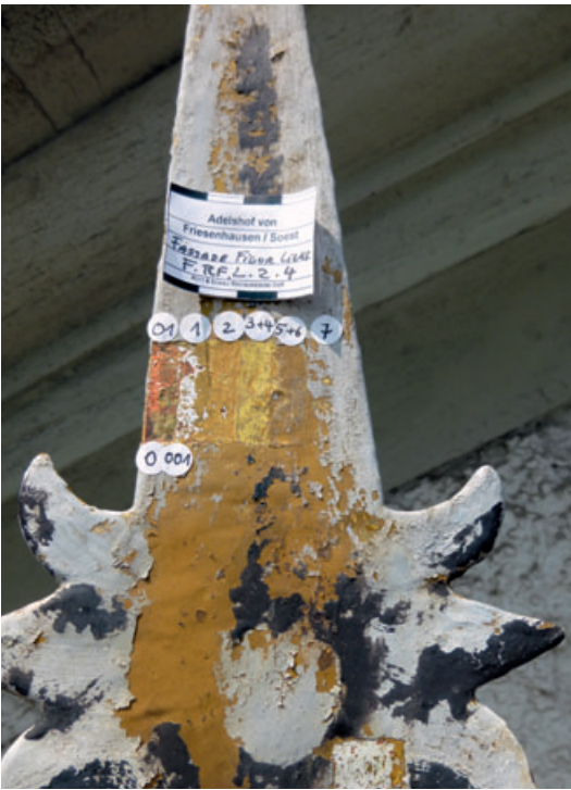
4 Detail der Speerspitze des links stehenden Kriegers mit Freilegungsstufen zur Verdeutlichung der vorhandenen Farbschichten während der Befunduntersuchung.
