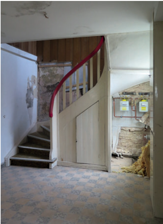
7 Eingangsflur mit der 1939/40 eingebauten Treppe, deren Antritt den Bereich der dafür entfernten Zisterne einnimmt. Foto 2018.
