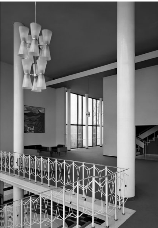
6 Hauptfoyer des Heinz-Hilpert-Theaters (Obergeschoss) mit zahlreichen Details aus der Erbauungszeit. Foto 1994.
