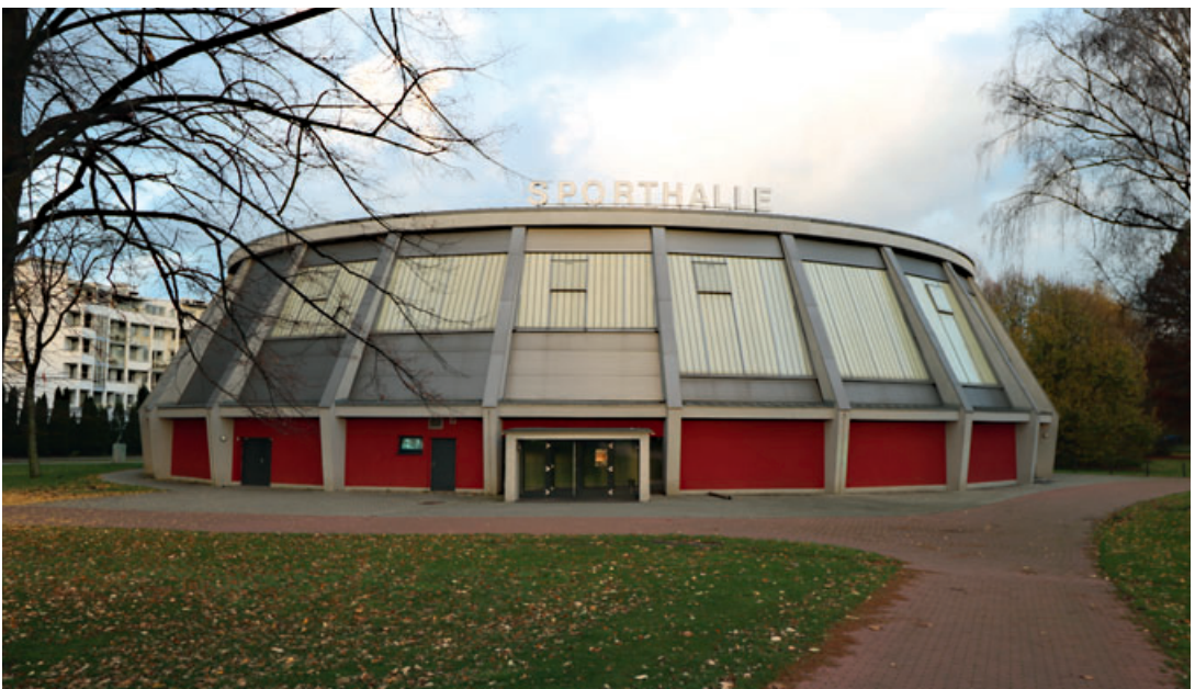
9 Rundsporthalle an der Kurt-Schumacher-Straße, 1967/68, System Dörken & Fröhlich unter Mitarbeit des Architekten Georg Flinkerbusch. Nach Sanierungsmaßnahmen (flächige Wärmedämmung) ist das markante Stahlbetonskelett mit den Füllungen in Waschbeton nicht mehr ablesbar. Foto 2017.
