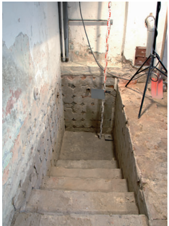
11 Ehemalige Mikwe nach vollständiger Ausgrabung; gut erkennbar ist der Mörtel, an dem die Fliesen hafteten; in der Bildmitte der Wasserzulauf, rechts oben der Kaminschacht. Foto 2017.
