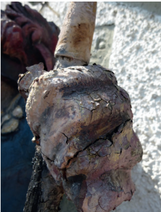
3 Detail der Hand der rechts stehenden Giebelfigur mit beschädigtem Farbschichtpaket. Vorzustand 2017.
