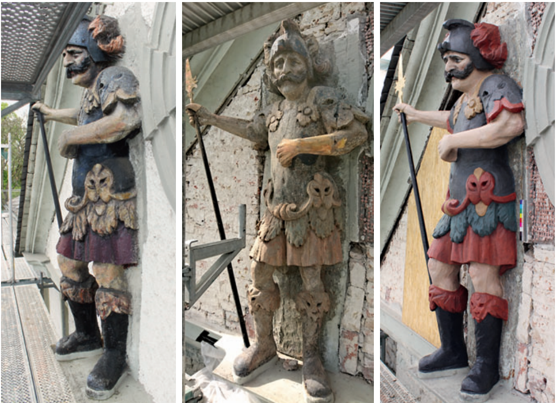
6 Der links stehende Krieger, links: Vorzustand, Mitte: Zwischenzustand nach Abnahme der Überfassungen und rechts: Endzustand nach Bearbeitung der Schadstellen im Holz und Neubemalung nach Originalbefund. Fotos 2017.
