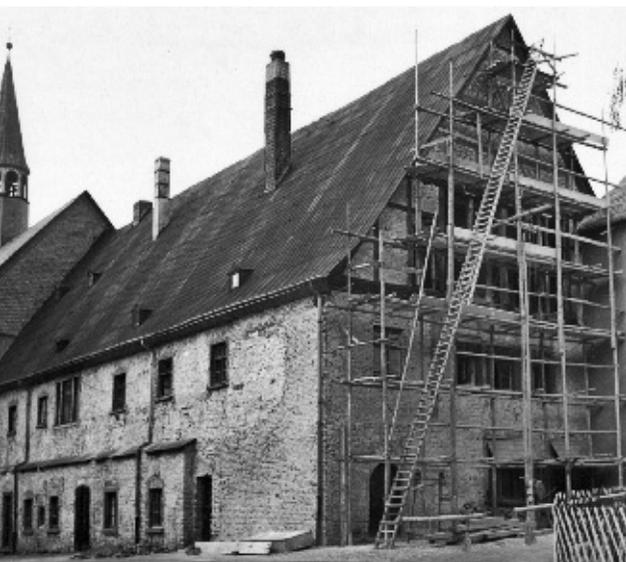
4 Ostflügel von Südwesten. Sanierung und Umbau zum Jugendheim 1959/60. An der Fassade ablesbar ist noch der Umbau des Gebäudes zu Wohnzwecken nach der Säkularisation 1803. 1959.
