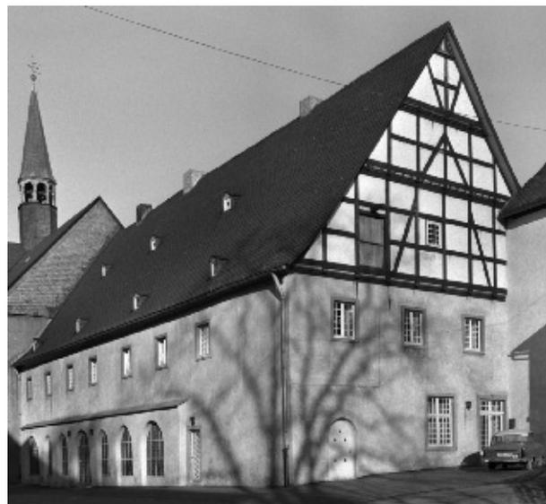
5 Ostflügel von Südwesten. Nach 1945 ist der Versuch unternommen worden, den Zustand vor 1803 teilweise zu rekonstruieren, u. a. durch Wiederherstellung der Öffnungen des Kreuzgangs (mit moderner Verglasung). 1963.
