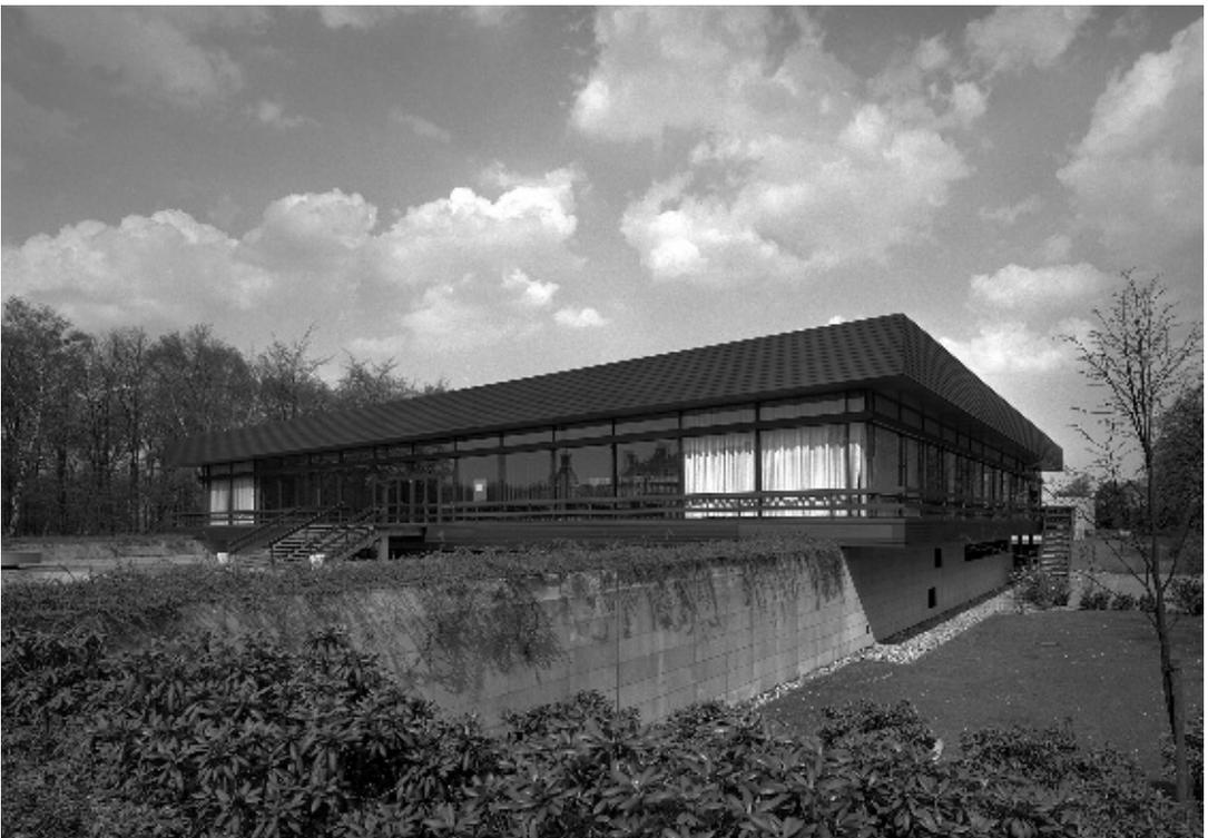
5 Mensa von Südwesten in der den Baukomplex prägenden Materialität. Das verglaste Obergeschoss mit der auskragenden Boden- und Deckenplatte gibt dem Gebäude eine stark horizontale Ausrichtung. 1975.
