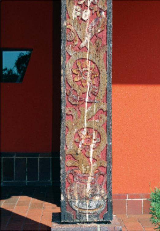
8 Der untere Teil des mittleren Ständers nach der Holzfestigung und dem Ausspänen von Rissen mit Hanf und Balsaholz sowie dem Kitten von Fehlstellen mit Korkmehl, Sägemehl und Arbocel. 2015.
