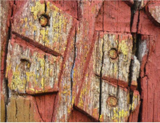
4 Durch Witterung und Sonneneinstrahlung stark degradierte Farbfassungs- und Holzoberfläche. 2012.
