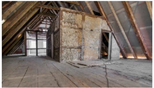
2 Der Innenraum des Dachgeschosses während der Bauphase 2015. Die Bruchsteinfüllungen in den eingestellten Fachwerkwänden sind aufgrund ihres erheblichen Gewichtes später in Teilbereichen entfernt worden.
