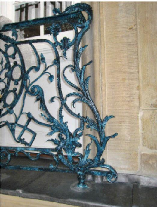
10 Restauriertes Fenstertürgitter, neue Abdeckung der Sohlbank aus Blei, Zustand 2012.
