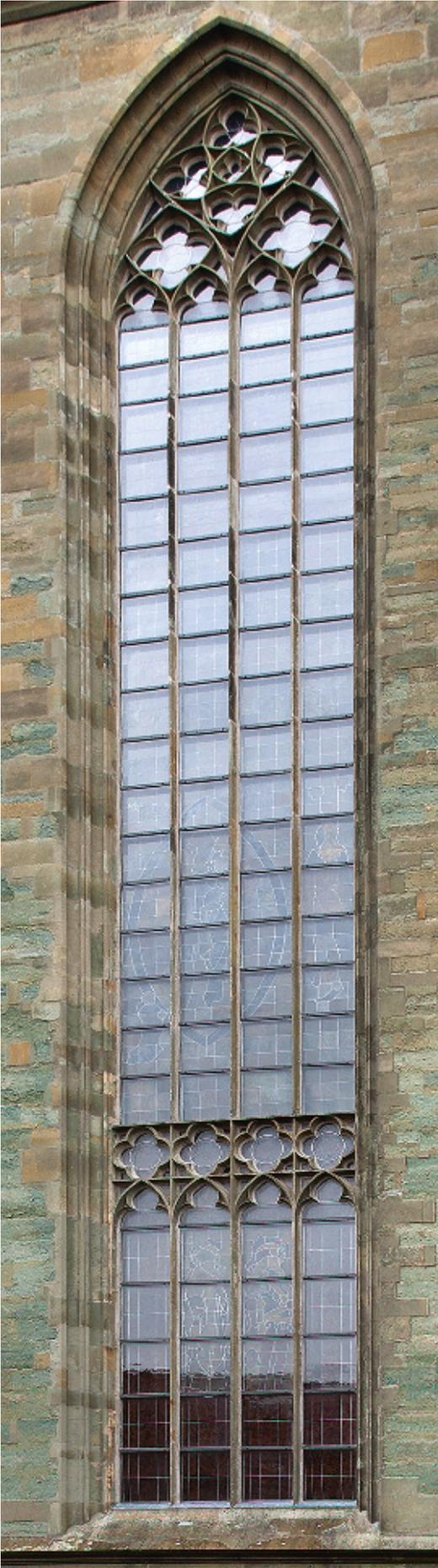
4 Soest, Wiesenkirche, Fenster nVI mit neu eingebauter Schutzverglasung. 2014.
