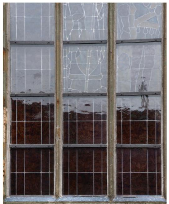
5 Soest, Wiesenkirche, Fenster nVI. Detail der neu eingebauten Schutzverglasung. 2014.
