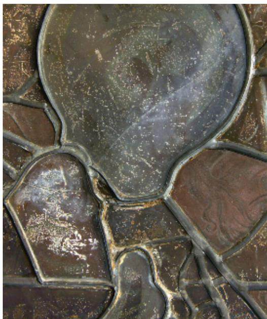
4 Nordöstliches Chorfenster: Korrosionsschäden hinter der trockenen Doublierung der Köpfe von Maria und dem Jesusknaben. Zustand vor der Restaurierung. 2012.
