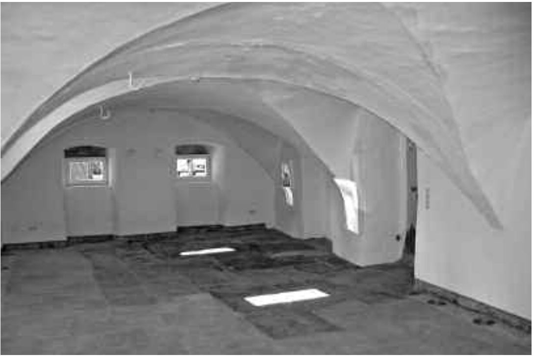
4 Der Gewölbekeller nach der Sanierung 2009.
