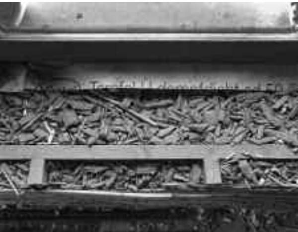
2 Innendämmung mit Leichtlehm und Holzhäckseln zwischen Holzlatten eingebracht. 2009.
