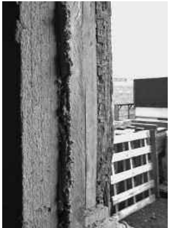
3 Innendämmung mit Holzweichfaserplatten im Mörtelbett in einem Fachwerkhaus. 2009.
