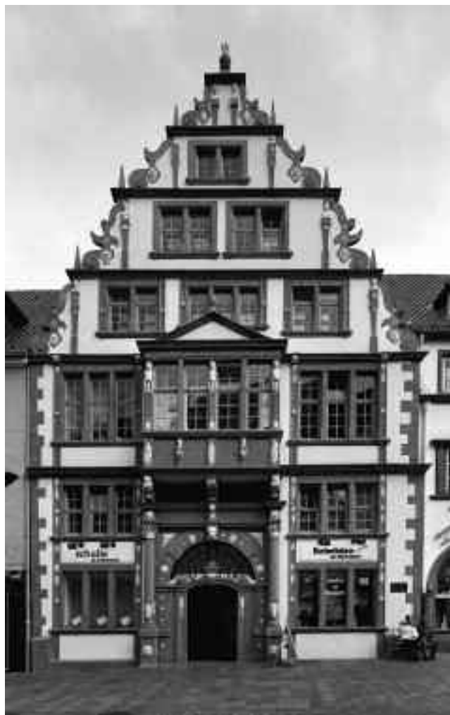
Haus Heising in Paderborn nach seiner Restaurierung 2009.
