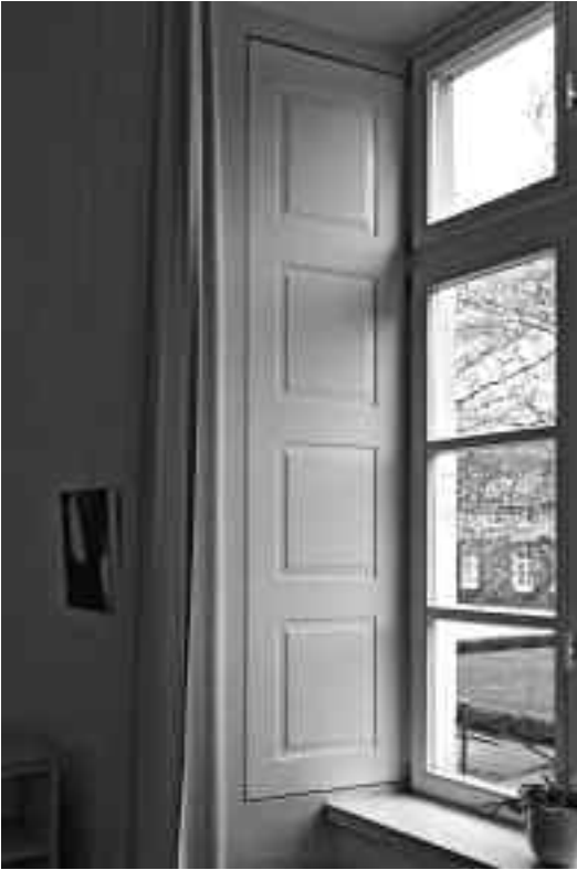
8 Schwerte (Kr. Unna), Haus Villigst, 1819. Der innen angebrachte Klappladen ist im geöffneten Zustand in der Fensterlaibung untergebracht und gestalterisch mit der gesamten Raumdekoration vereinheitlicht. 2009.
