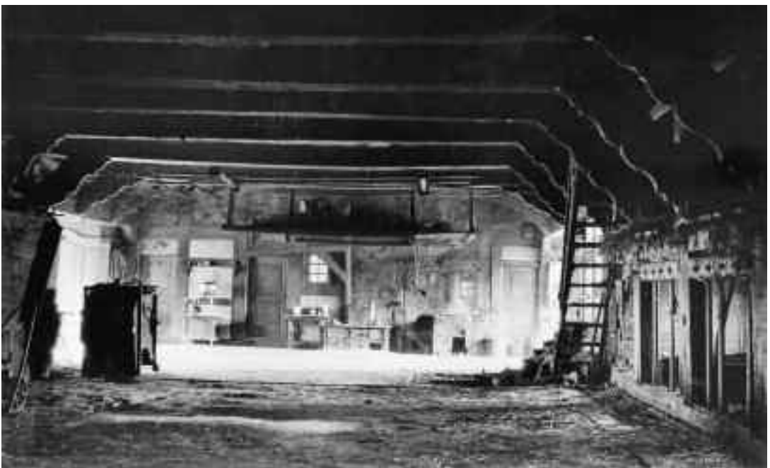
1 Rahden-Preußisch Ströhen (Kr. Minden-Lübbecke), Hof Rohlfing, 1776/80. Diese durch viele Veröffentlichungen klassisch gewordene Aufnahme zeigt idealtypisch die Küche im niederdeutschen Hallenhaus: Am hinteren Ende der Wirtschaftsdiele ist mittig im Flett das offene Feuer des Küchenherdes mit Rauchfang angeordnet, das seit der Mitte des 19. Jahrhunderts von der eisernen Kochmaschine abgelöst wird. 1934.
