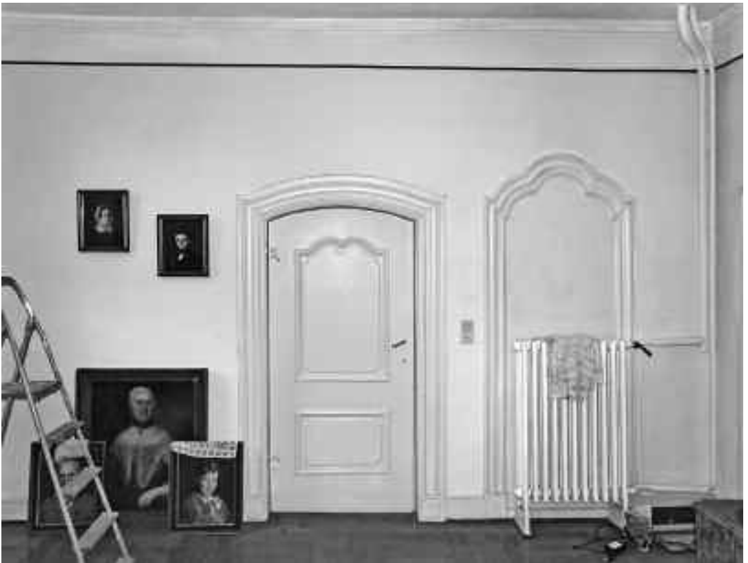
12 Hagen-Westerbauer, Haus Harkort, 1756. Die rechte der beiden Öffnungen dürfte einstmals einen beide Erdgeschossräume beheizenden Ofen aufgenommen haben. 2008.
