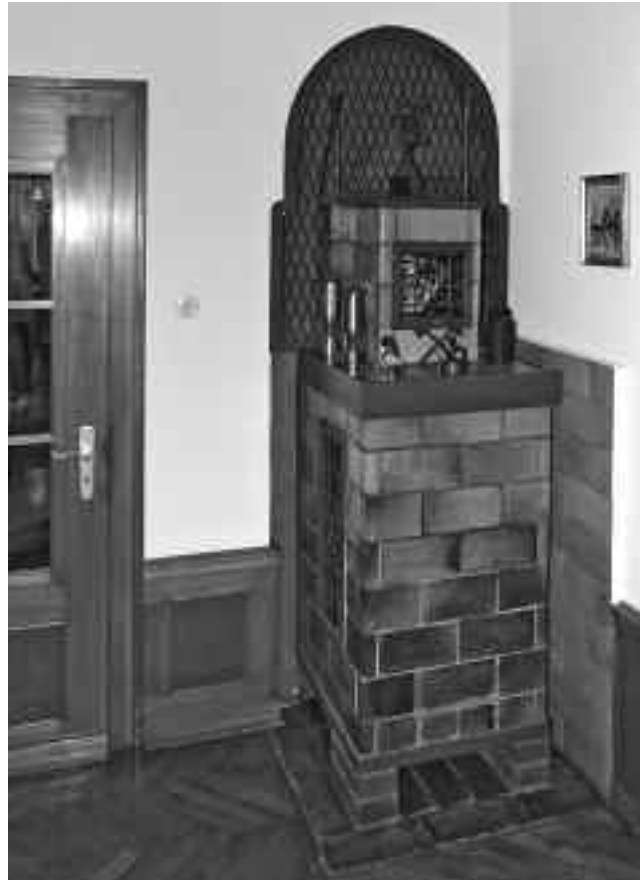
14a/b Siegen, Einfamilienhaus von 1948/49 an der Spandauer Straße. Keramik-Warmluftheizung; oben: Feuerseite; unten: Keramikkörper.
