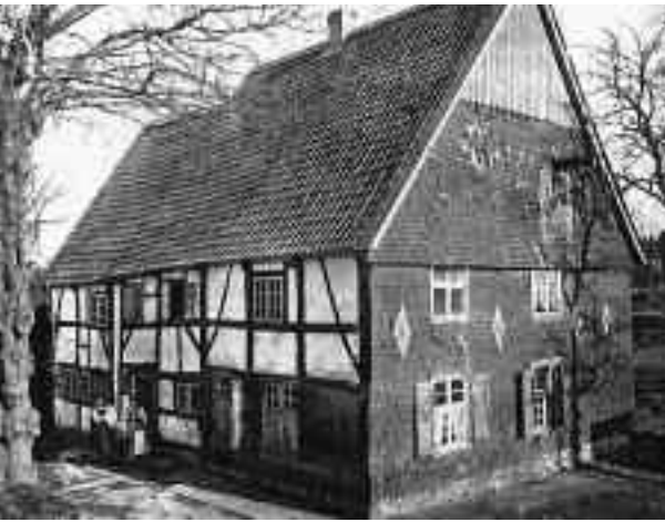
6a/b Sprockhövel (Kr. Ennepe-Ruhr), Hauptstraße 85; Mitte 18. Jahrhundert. Links: Zustand vor 1918 mit Verschindelung der Giebelwand; rechts: nach Abnahme einer noch jüngeren Verschieferung wurden die Auskerbungen für die nachträgliche Anbringung der die Verschindelung tragenden Latten an den Gefügehölzern erkennbar. 1995.
