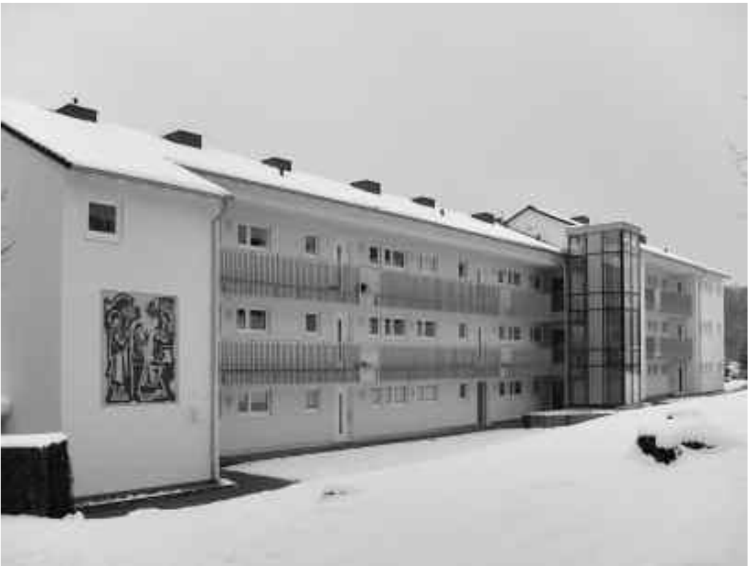
3 Siegen, Siedlung „Wensch“, Haus mit Laubengang nach der Sanierung im Jahre 2008.
