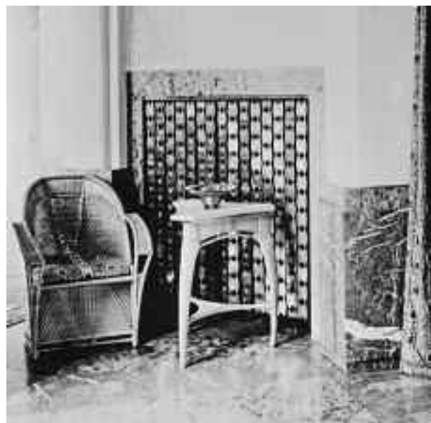
16a/b Beispiele aufwändiger Heizkörperverkleidungen aus dem ersten Drittel des 20. Jahrhunderts; oben: Detmold (Kr. Lippe), Arminstraße 11, 1919–1936; unten: Hagen-Ernst, Hohenhof, Stirnband 10, 1906. Um 1930.
