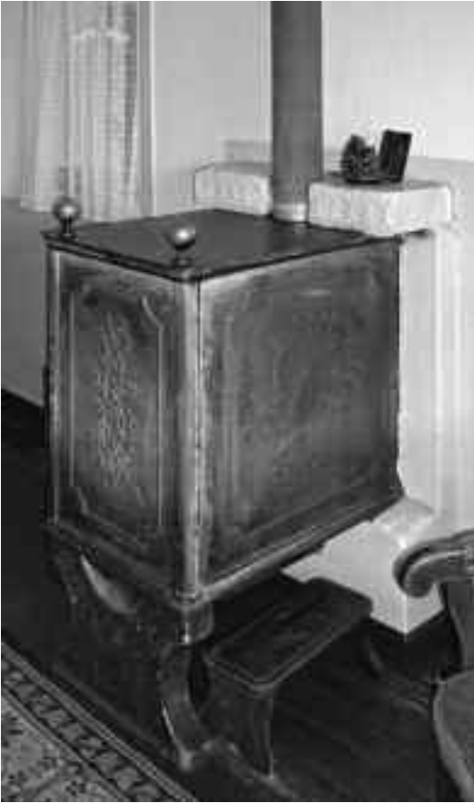
2a/b Stewede-Westrup (Kr. Minden-Lübbecke), Stewederbergstraße 22, 1862. Einer der wenigen in Westfalen-Lippe noch in Betrieb befindlichen Hinterladeröfen, jedoch zwecks besseren Zuges um ein Rauchabzugsrohr ergänzt; Blick in die Stube (links) und auf die Feueröffnung beim einstigen Küchenherdfeuer auf der Diele (rechts); davor der Torf-Behälter von 1811. 2009.
