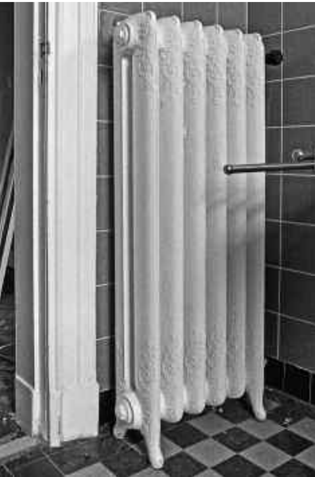
15 Frei stehender Rippen-Heizkörper aus Gusseisen mit floraler Zier, frühes 20. Jahrhundert. Emsstraße 67 in Rheine (Kr. Steinfurt). 1989.
