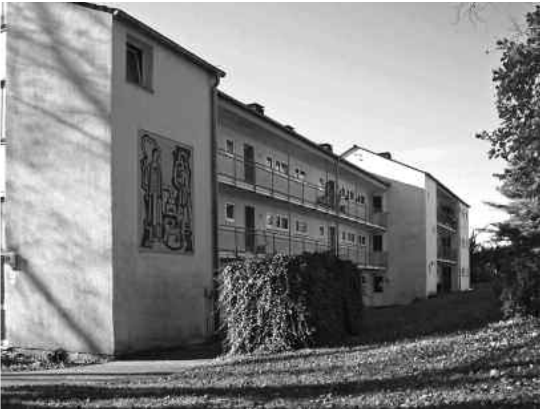
2 Siegen, Siedlung „Wensch“, Haus mit Laubengang vor der Sanierung 2001.
