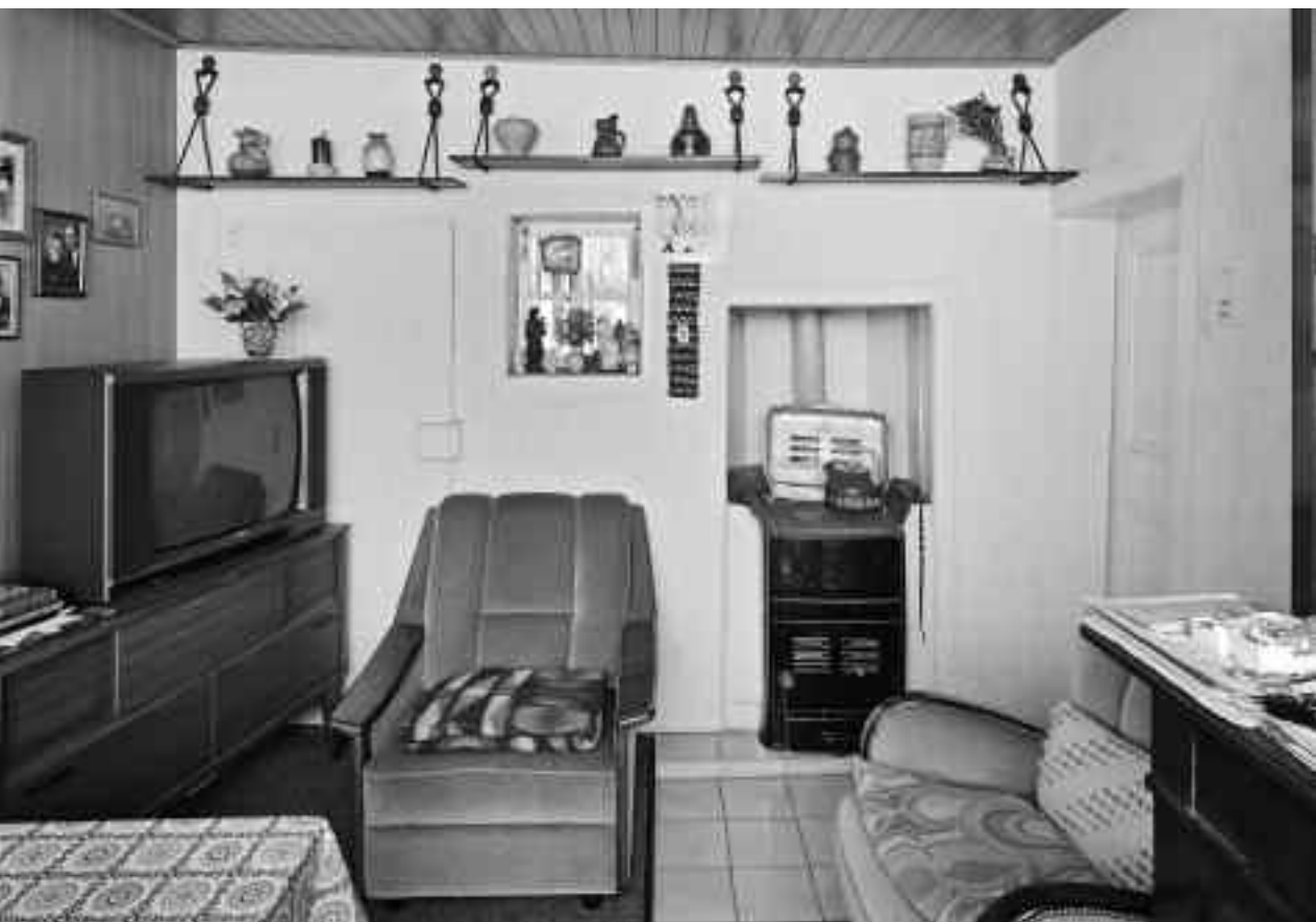
11 Horneburg (Kr. Recklinghausen), Horneburger Straße 28, um 1840. Der Ofen ist in die Wand eingestellt, wird von der Stube aus beheizt und gibt – mit einer Metallplatte verkleidet – auch an den dahinter gelegenen Raum Wärme ab. 1999.
