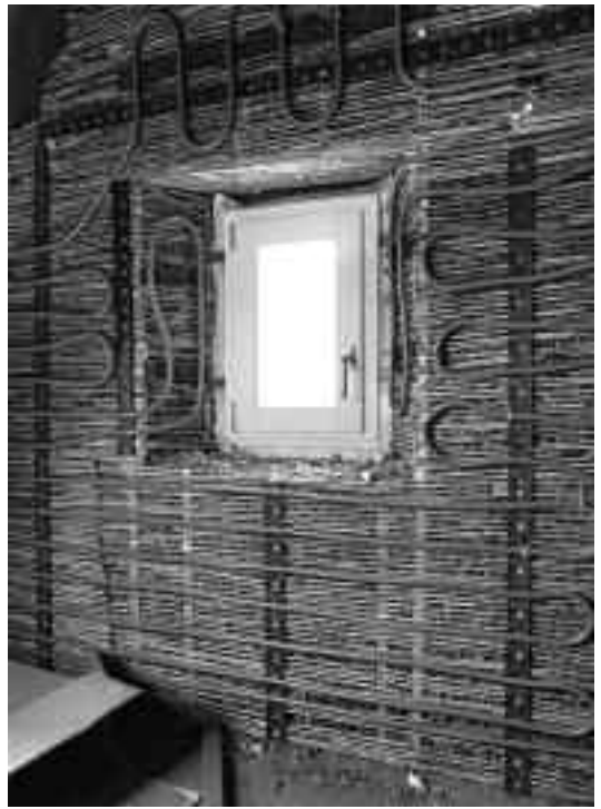
1 Innendämmung mit Leichtlehm und Wandheizung in einem Fachwerkhau. 2009.
