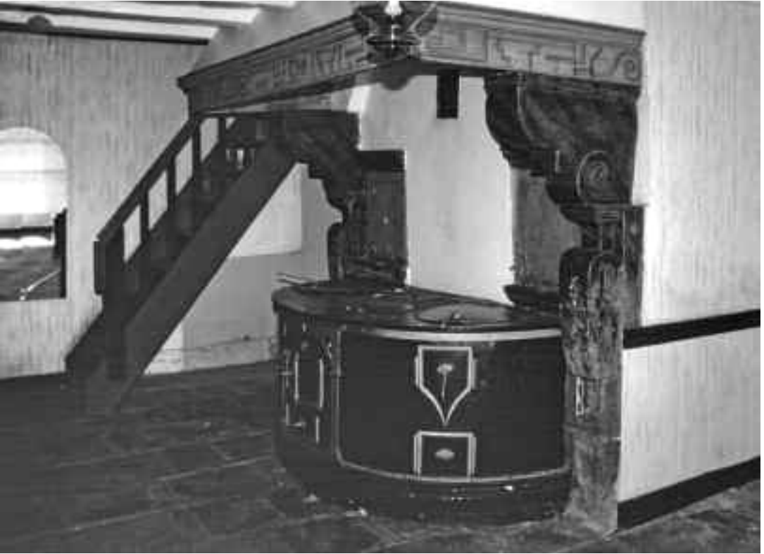
3 Hattingen, Zum Ludwigstal 2, 1839. Der eiserne Herd ( Fournaise ) wurde wohl um 1860 an die Stelle und unter den Rauchfang des offenen Küchenfeuers gestellt. 2005.
