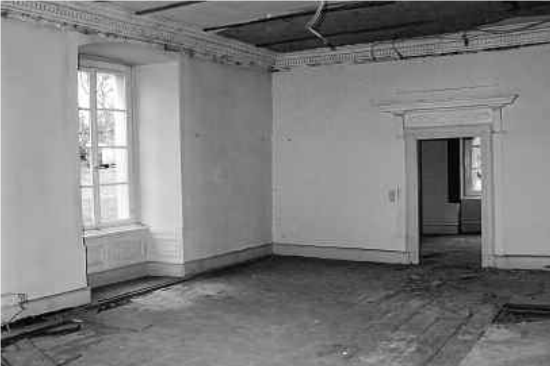
3 Der große Saal im Nordflügel vor der Sanierung 2007.
