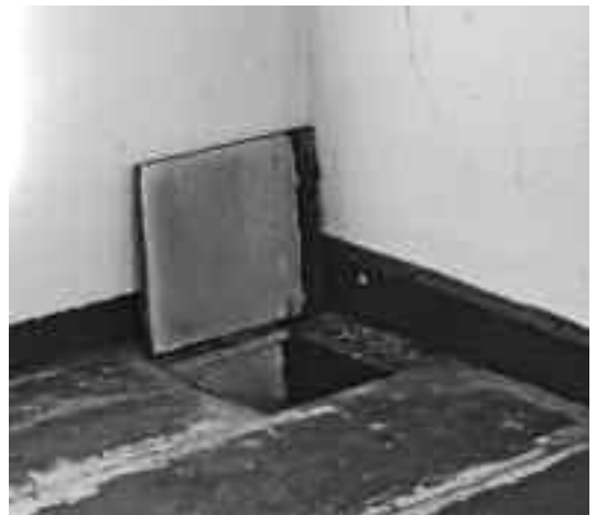
10 Dortmund-Brakel, Rüpingstraße, um 1850. Warmluftöffnung der über der Stube gelegenen Schlaf-Kammer in geöffnetem Zustand. 2008.
